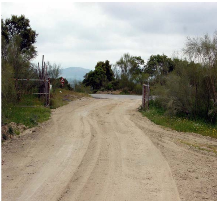
(Foto 2). Camino de acceso en su conexión con carretera a Fuente Camacho.
