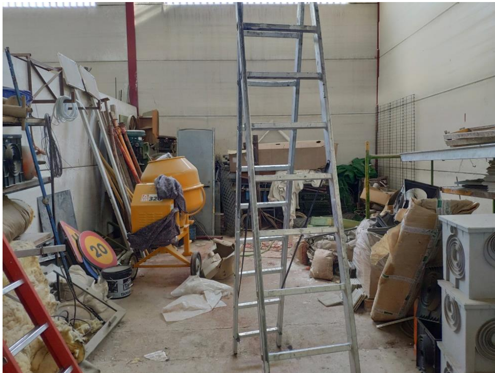
Imagen 10: Almacén de albañilería (2)
