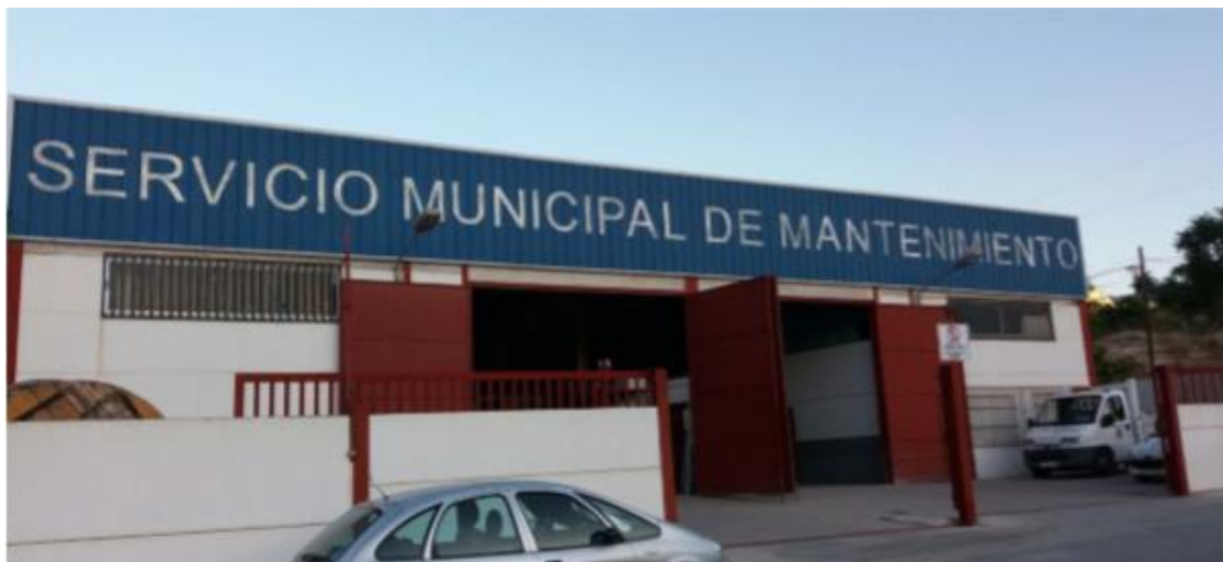
Imagen 6: Fachada principal nave de mantenimiento.
