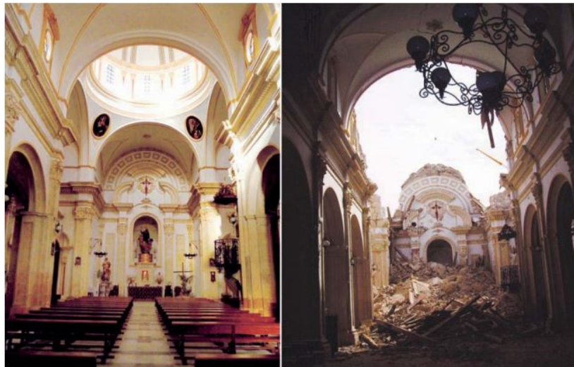
Figura 4.1 Crucero de la iglesia de Santiago antes y después del terremoto.
