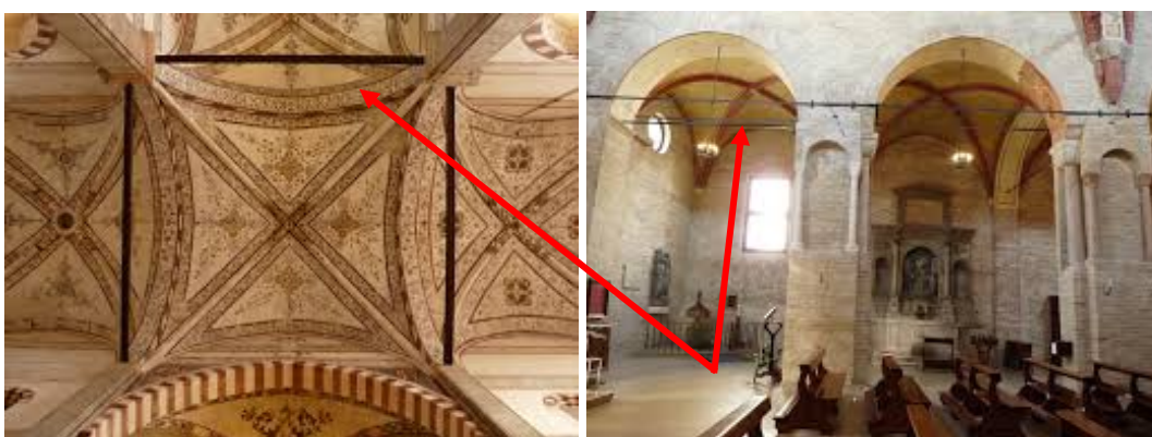
Figura 8.5 Arcos reforzados mediante tirantes.
