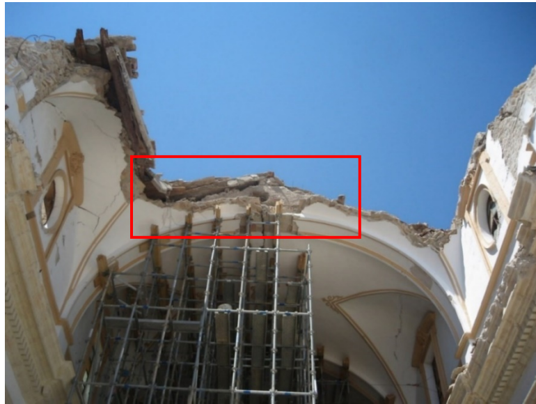
Figura 7.1 Losa de hormigón armado sobre la cubierta de madera.
