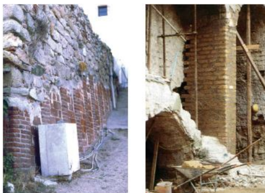
Figura 8.1 Sustitución de las zonas dañadas.
