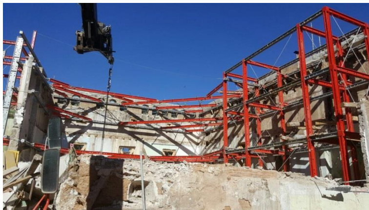
Fig. 11. Estabilización mixta en Teruel. Fuente: RH Estructuras.
