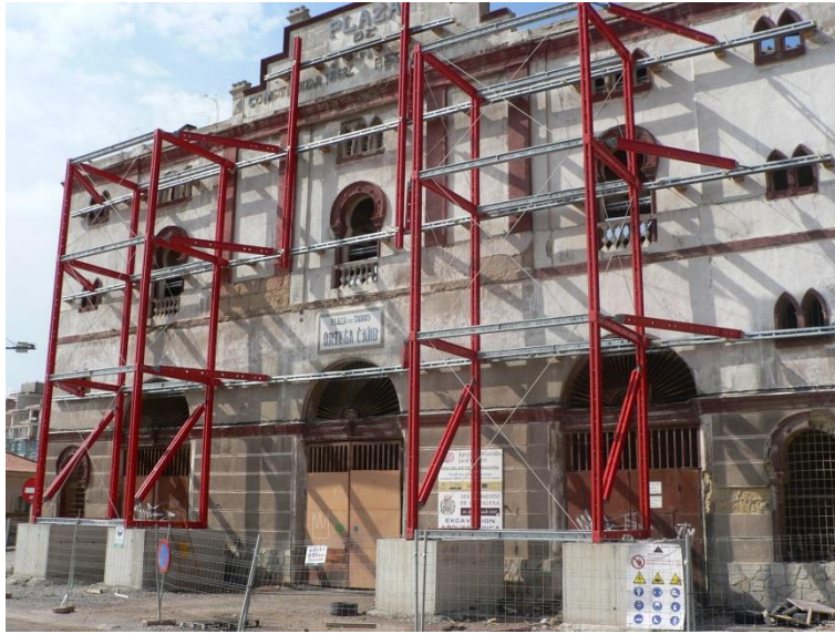
Fig. 12. Estabilización exterior contrapesada. Plaza de toros de Cartagena (Murcia). Fuente: Sermaco.
