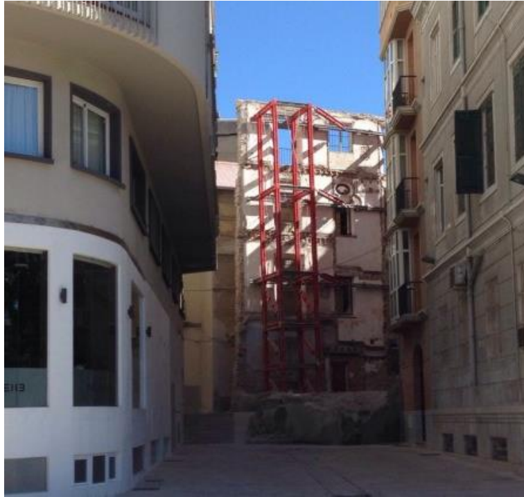
Fig. 10. Estabilización interior contrapesada en Málaga. Fuente: RH Estructuras
