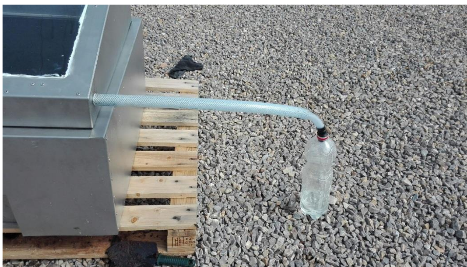
Figura 29- Sistema de extracción de agua del prototipo.
