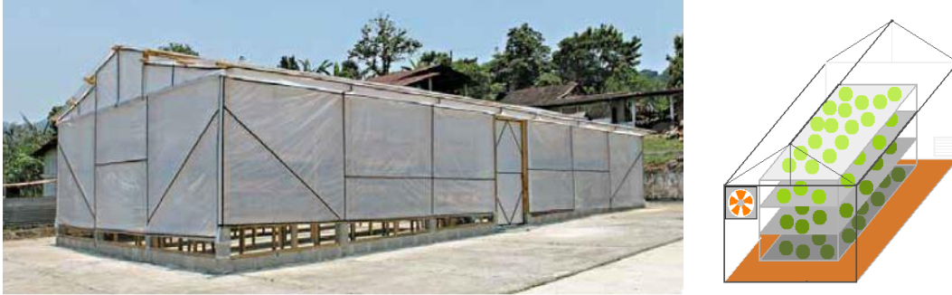
Figura 10 - Secador solar de efecto invernadero, [7].
