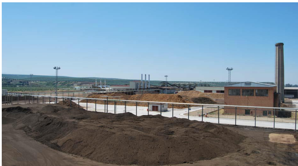
Figura 16 - Planta de secado y reducción de lodos oleícolas con cogeneración en Linares (Jaén), [11].
