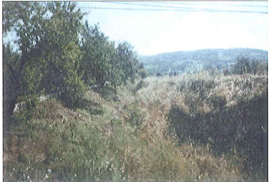
Foto 1.- Se observa la sección del cauce repleto de maleza.
