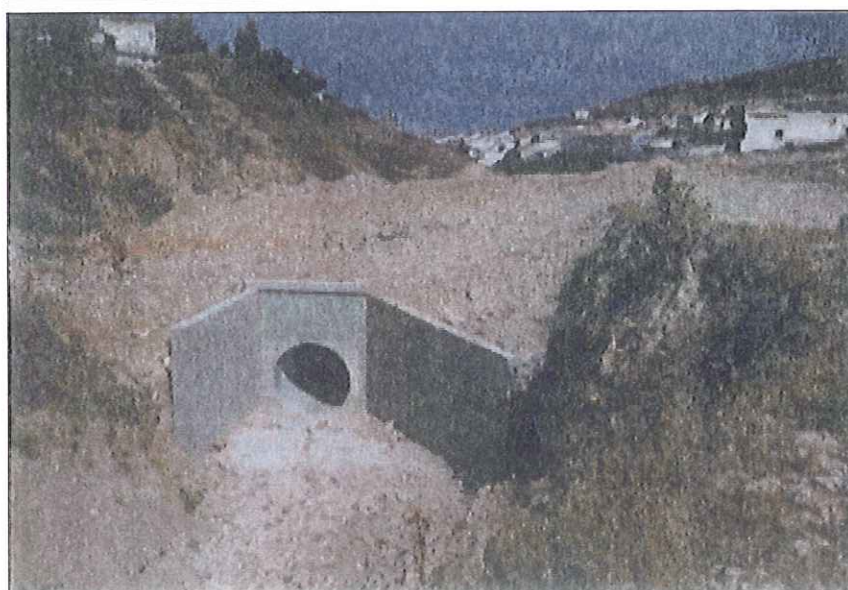
Foto 2.- Inicio tramo entubado con D= 2000.
