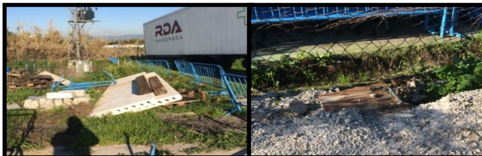
Figura 4.2: Limpieza y replanteo de zona exterior (Fuente: Autor)
