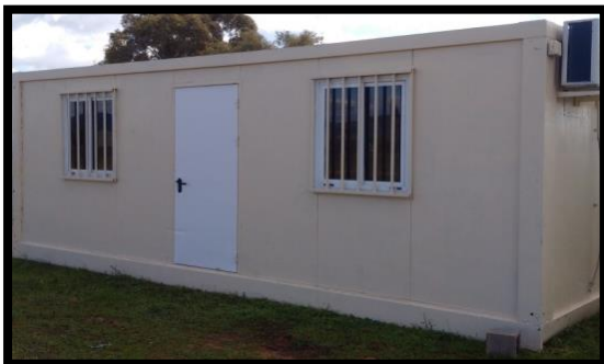
Figura 2.30: Modulo sanitario (Fuente: Autor)
