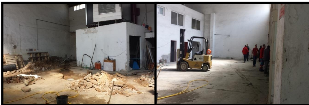
Figura 4.12: Acondicionamiento de nave – saneamientos y pavimentación (Fuente: Autor)
