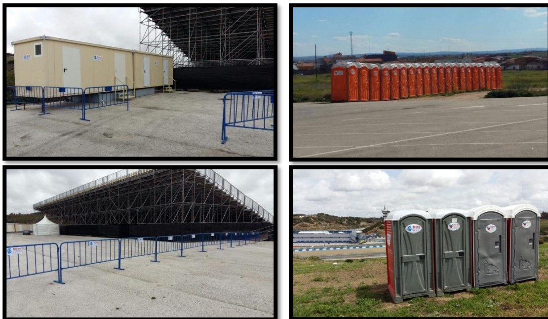
Figura 2.46: Montaje de vallas y sanitarios GP España 2015 (Fuente: Web FERSA)
