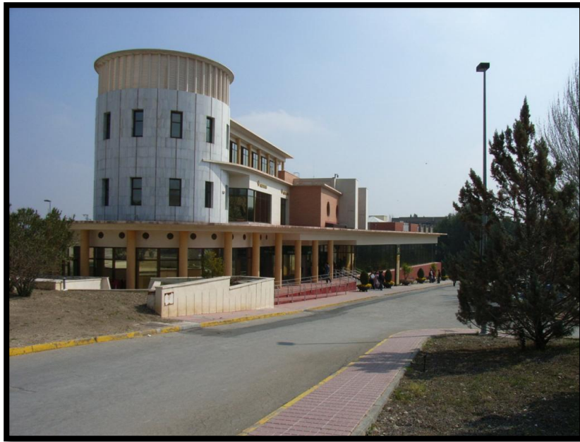
Ilustración 6. Fotografía del edificio Zabaleta 2 (Fuente Ujaen.es)
