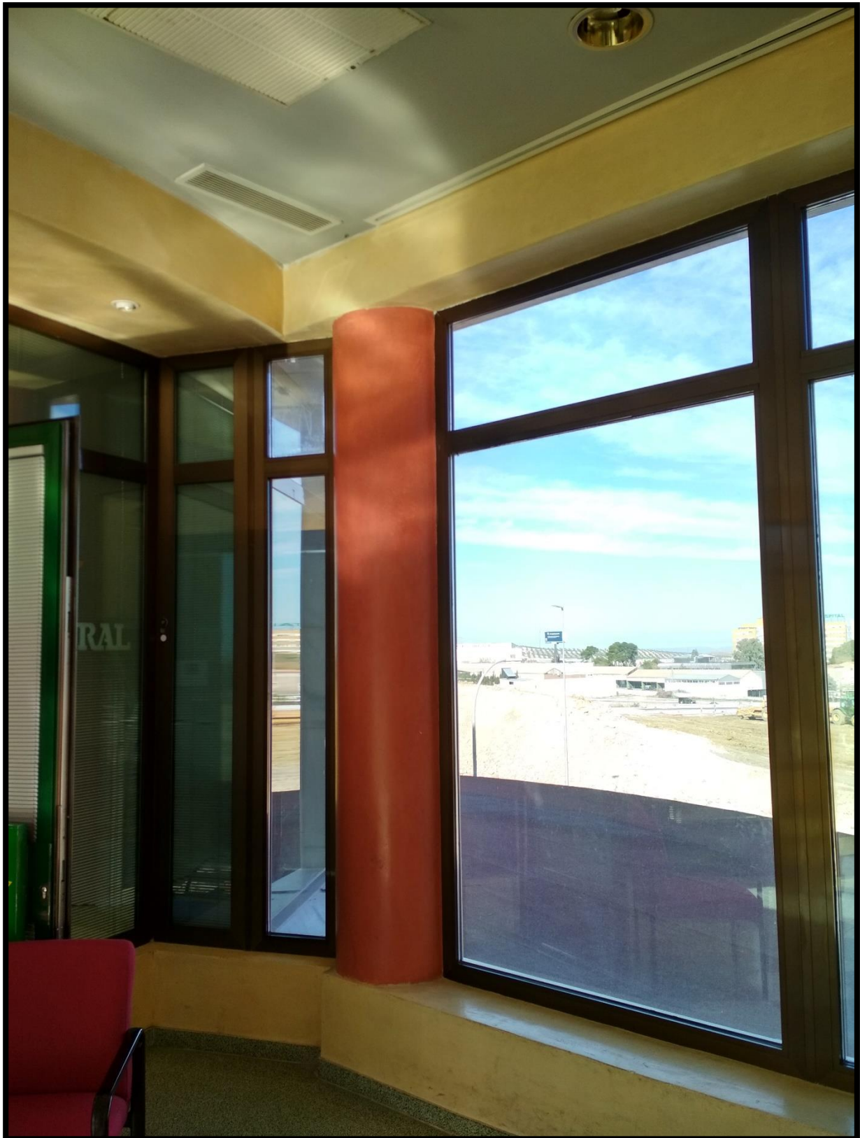
Ilustración 75. Detalle de la columna ubicada junto la entrada de la sucursal.
