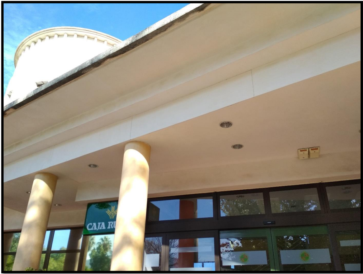
Ilustración 72. Detalle del techo en la entrada principal del edificio.
