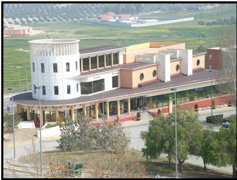
Ilustración 5. Fotografía del edificio Zabaleta (Fuente Ujaen.es).
