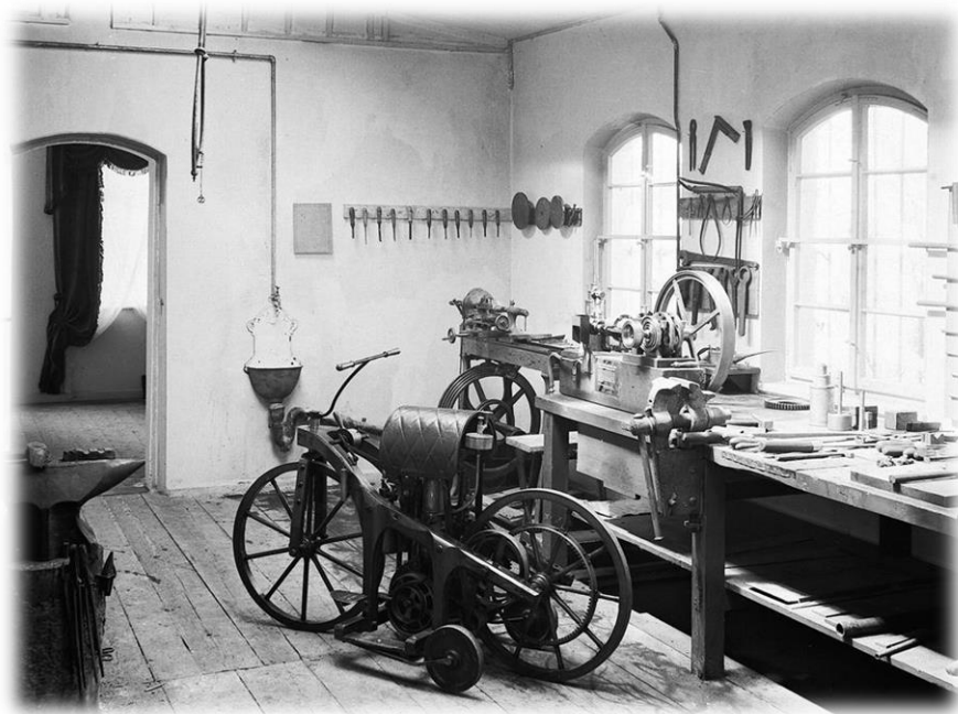
Ilustración 13. Primera y única Reitwagen construida con variaciones de su diseño inicial.
