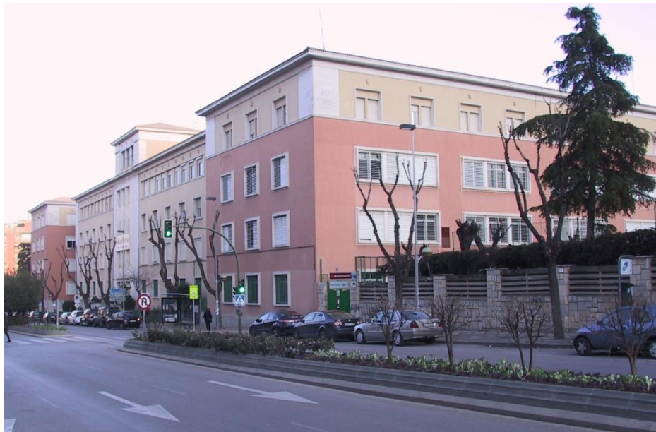
Figura 7.3.1.1. Edificio de Maristas (Colegio Santa María de la Capilla Jaén, 2012)
