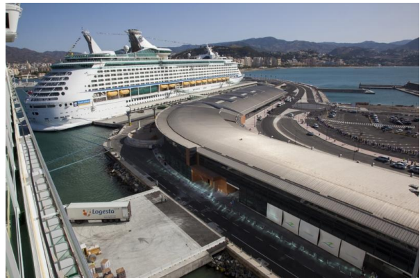
Fig 57. Terminal de Cruceros del puerto de Málaga
