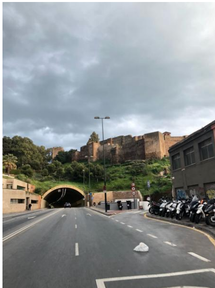
Fig 72. Túnel de la Alcazaba
