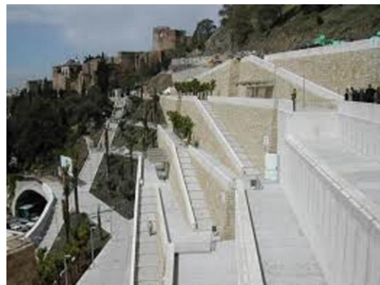
Fig 71. Rehabilitación de la extinta Coracha
