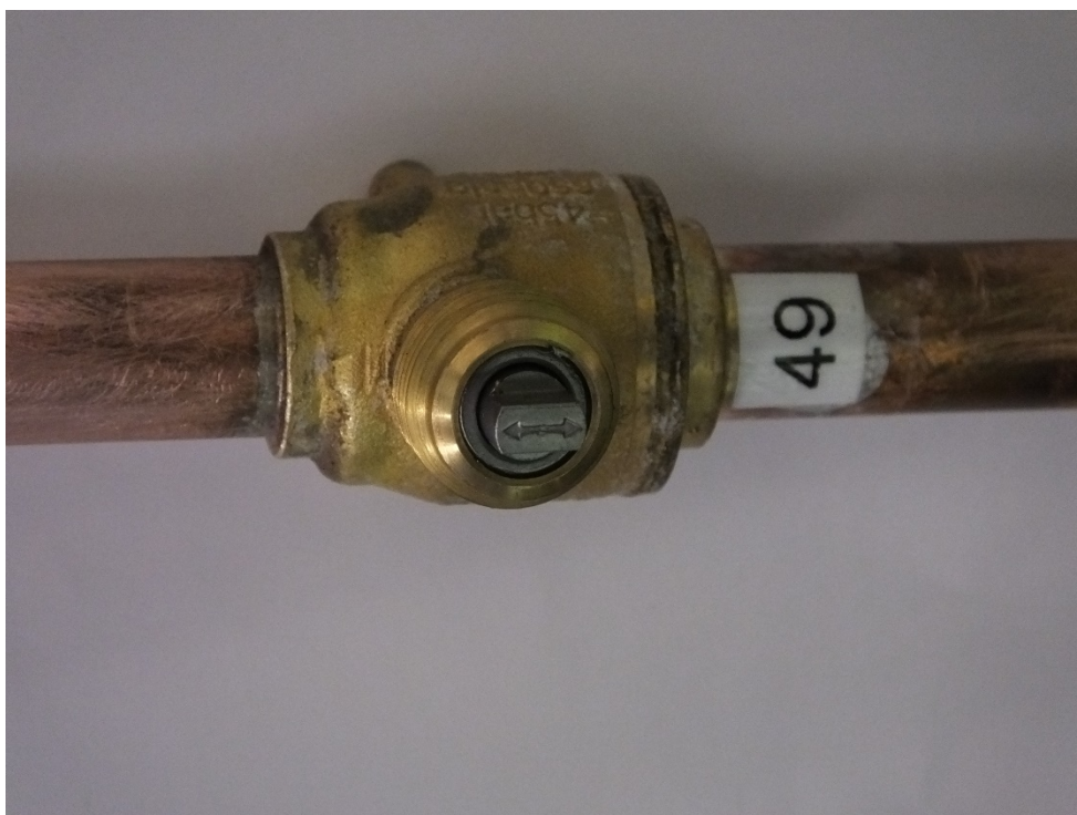
Ilustración 38: Válvula de bola abierta
