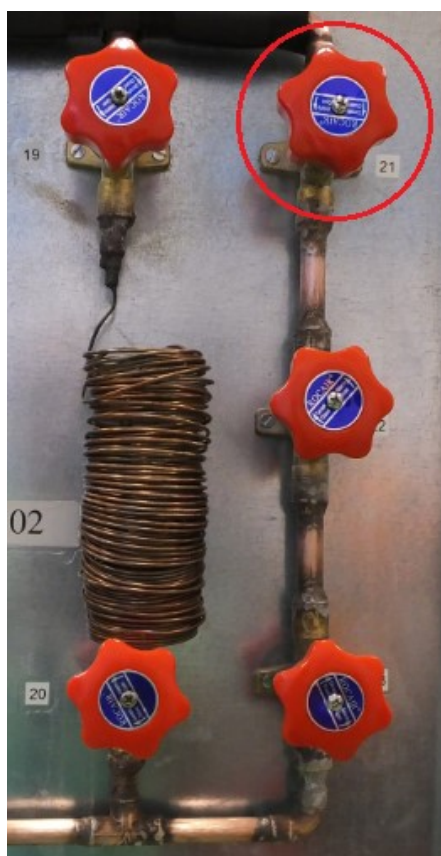
Ilustración 60: Válvula de volante 21 y tubo capilar
