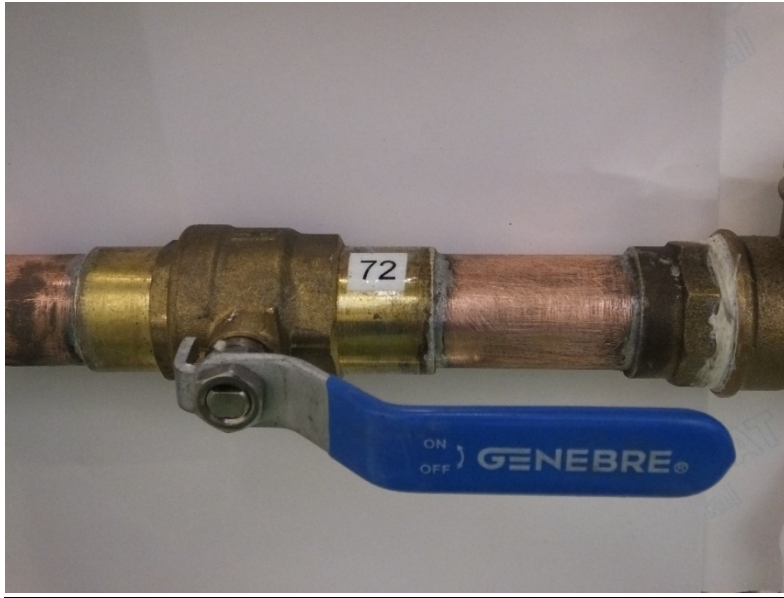
Ilustración 29: Válvula de bola (Agua)
