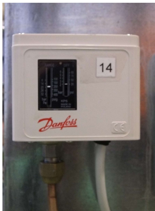
Ilustración 13: Presostato de alta
