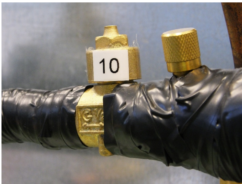
Ilustración 10: Válvula de bola con obús
