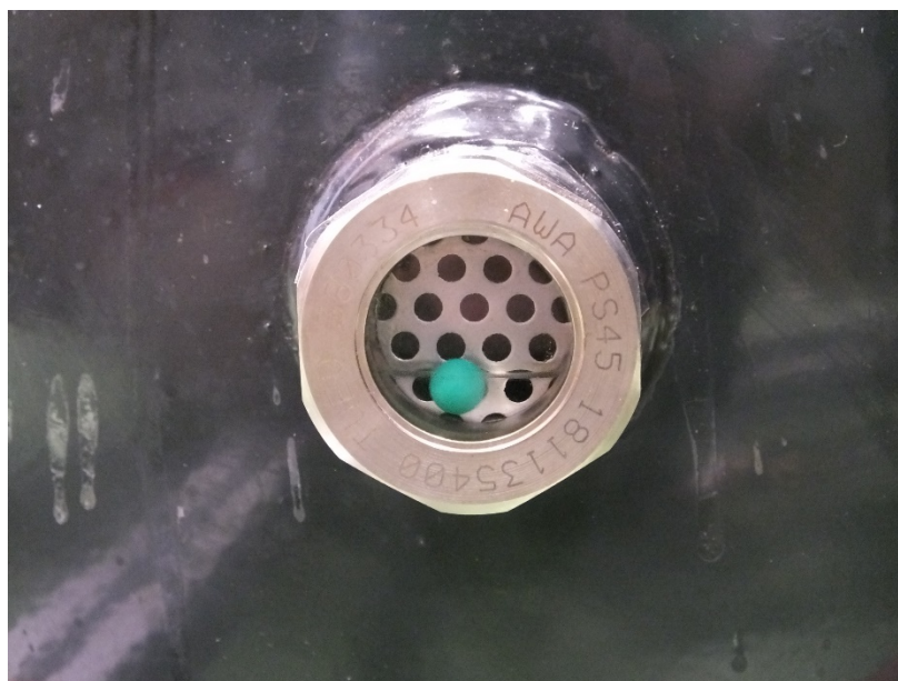
Ilustración 59: Visor de refrigerante
