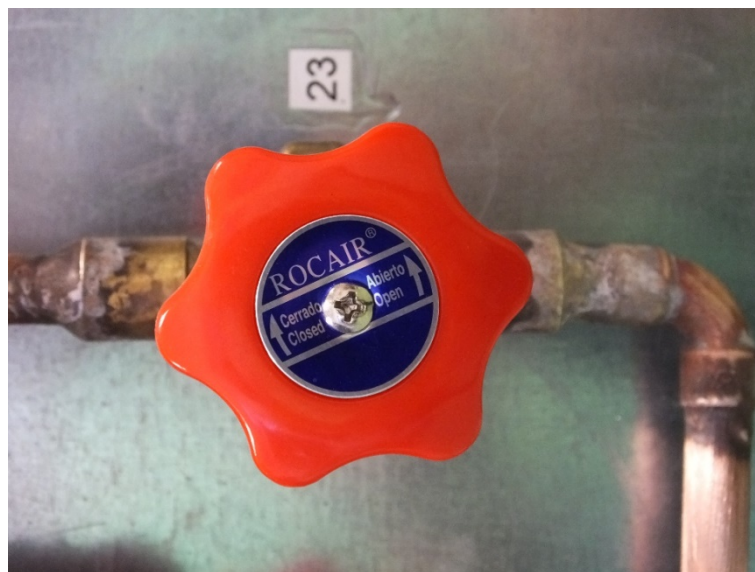
Ilustración 16: Válvula de volante
