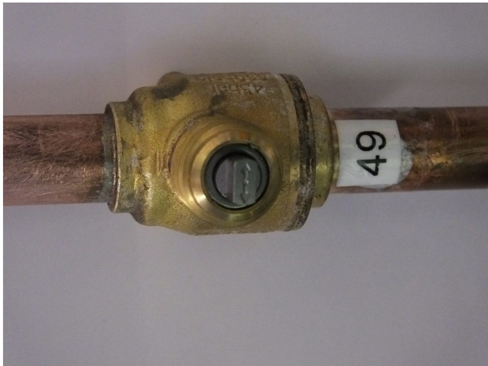
Ilustración 37: Válvula de bola cerrada
