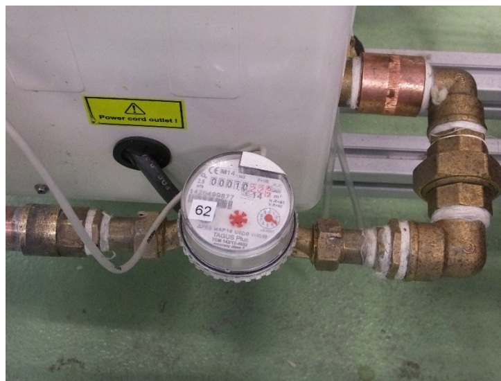
Ilustración 28: Caudalímetro agua de impulsos
