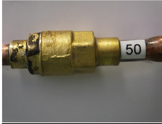
Ilustración 26: Válvula antirretorno
