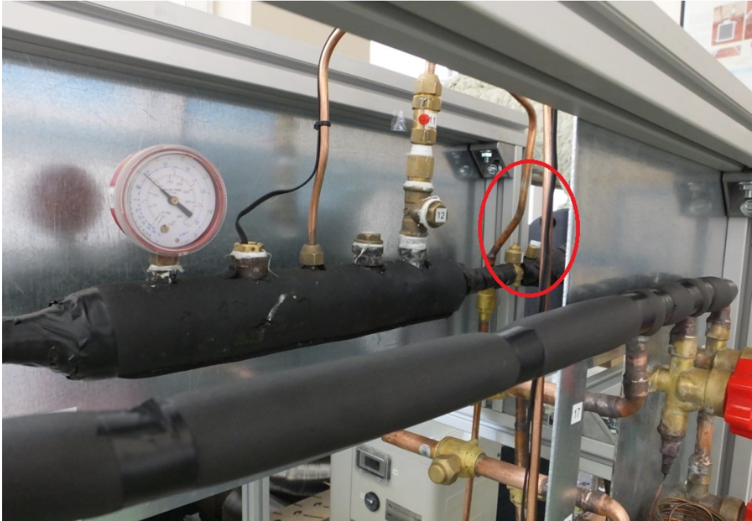
Ilustración 34: Localización válvula de obús 10
