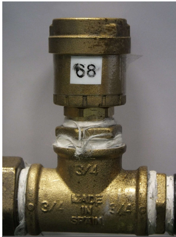
Ilustración 32: Purgador de aire
