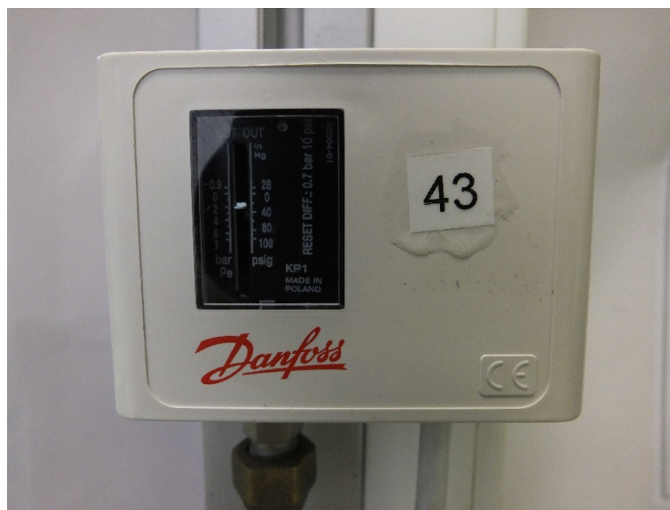
Ilustración 21: Presostato de baja
