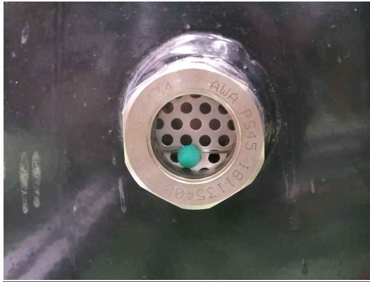
Ilustración 20: Visor de líquido depósito
