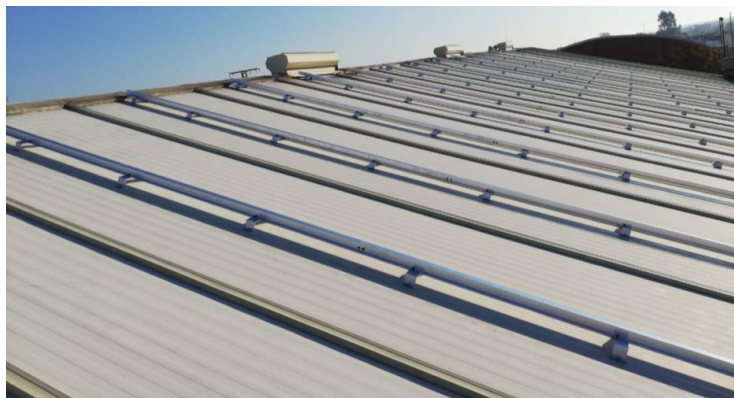
Figura 2- Detalle instalación estructura
