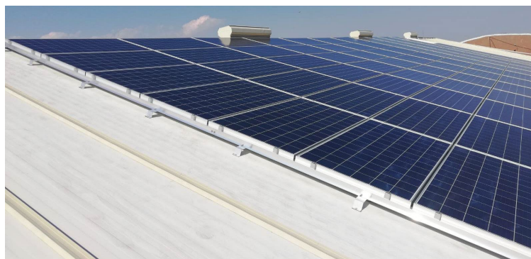
Figura 3- Detalle montaje módulos
