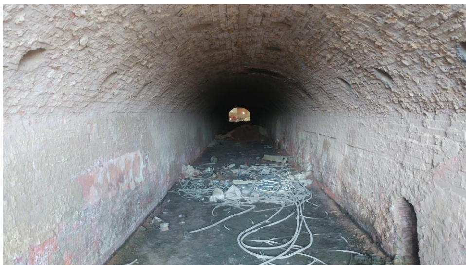
Ilustración 5: Horno Hoffman con quemadores de Gas. Fuente: Archivo fotográfico del autor.
