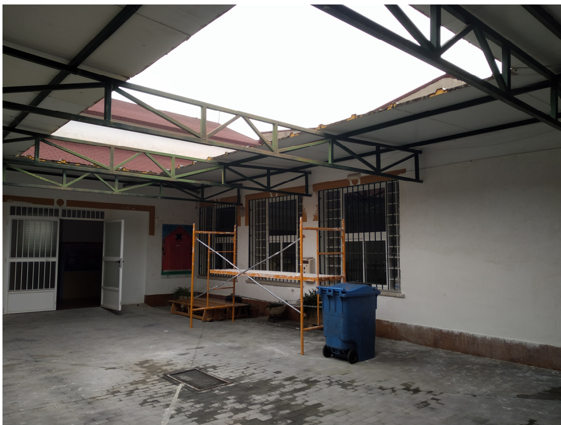
Imagen 16: Patio interior degradado
