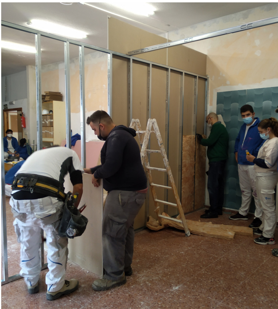
Imagen 18: Taller de montaje tabiquería en seco
