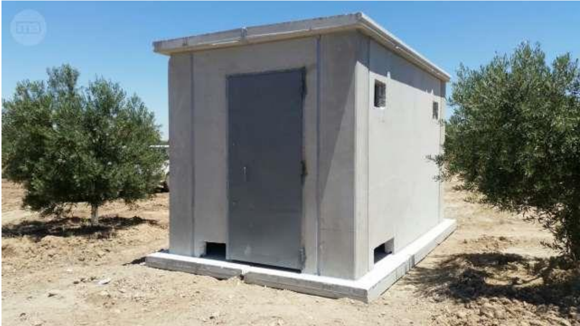
Imagen 30 – Caseta de hormigón armado prefabricada
