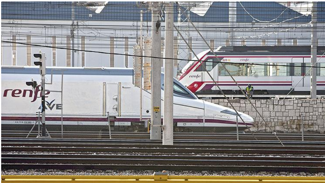
Figura 2.5. Electrificación y sistema de control de tráfico. Fuente: Itransporte
