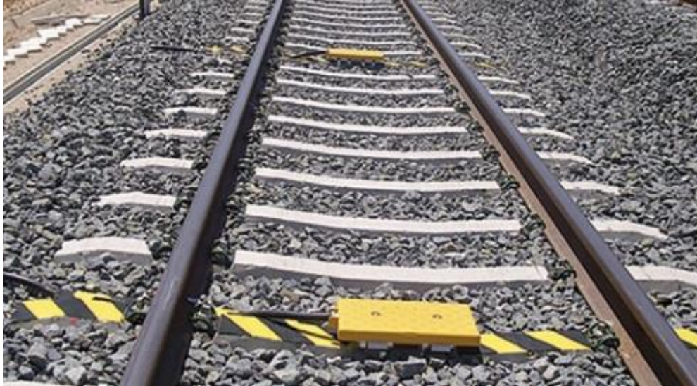
Figura 2.6. Vía convencional. Fuente: Inse Rail
