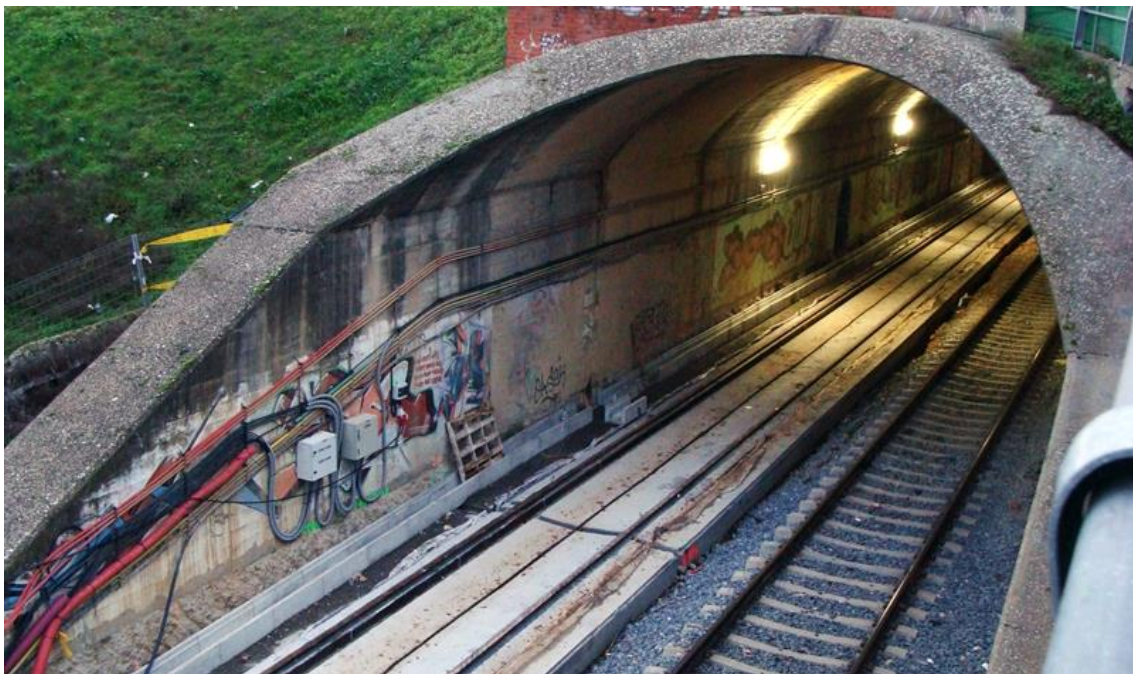
Figura 2.8. Túnel el Bolón (Zamora).
