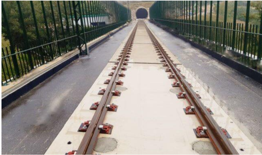
Figura 2.7. Vía en placa. Fuente: Mafex
