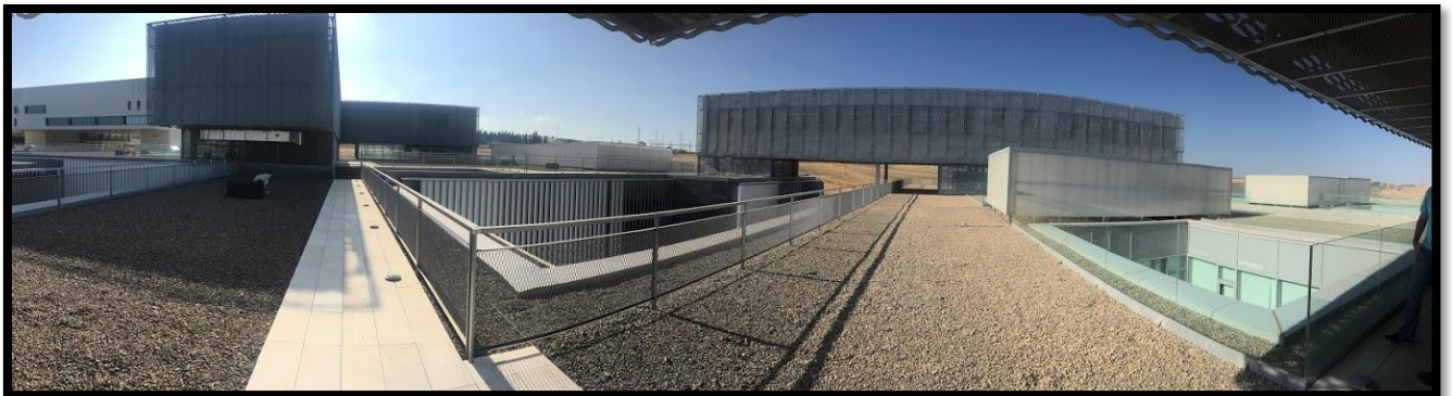
Figura 4.11. Vista panorámica del acceso de la cubierta al tramo recto.
