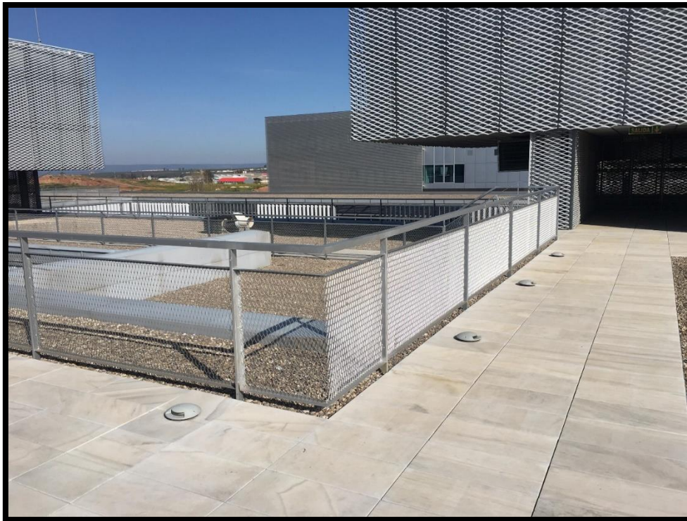
Figura 4.2. Baldosa en mármol como conexión de las zonas de la cubierta.
