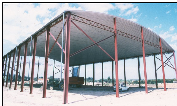
Figura 2.29: Solución adoptada para la nave de maduración
