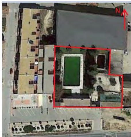
FIGURA 4.2.- VISTA AÉREA DE LA PARCELA
