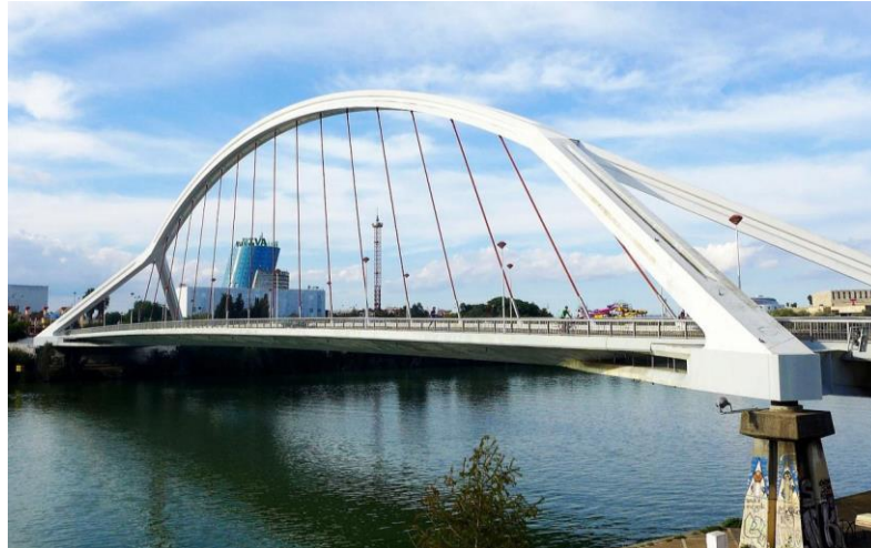
Ilustración 39 Puente de la Barqueta (Sevilla). Fuente: https://www.tripadvisor.es/Attraction_Review-g187443-d8837800-Reviews-Puente_de_la_Barqueta-Seville_Province_of_Seville_Andalucia.html
