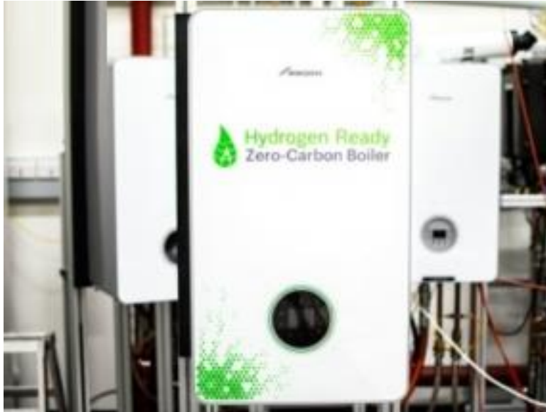
Ilustración 11. Caldera de hidrógeno doméstica Bosch.
