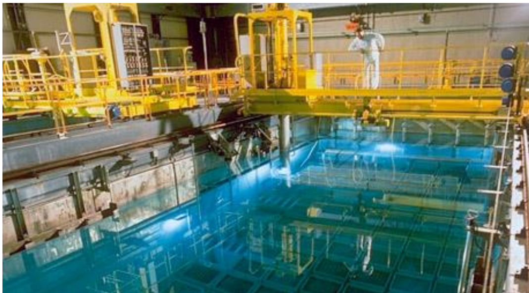
Ilustración 7. Piscina destinada al almacenamiento de combustible nuclear.
