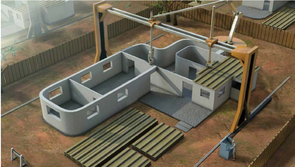
Ilustración 2.6: Construcción de una vivienda con impresión 3D [7]
