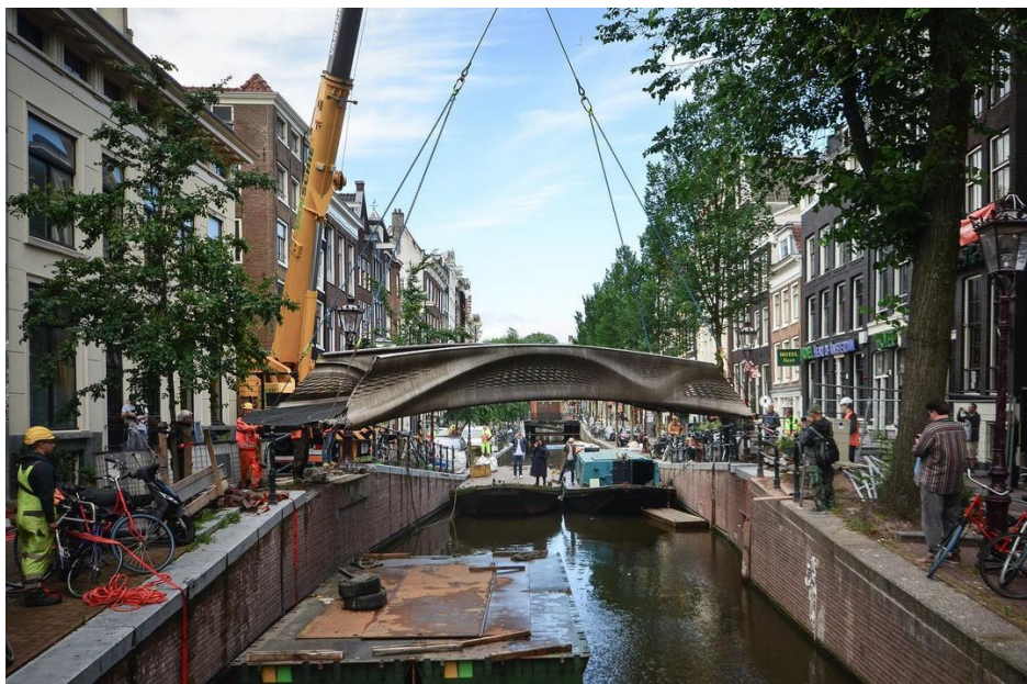
Ilustración 2.7: Colocación del primer puente impreso en 3D, situado en Ámsterdam [8].
