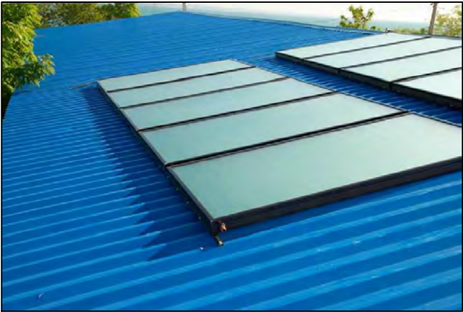
Detalle montaje placa sobre cubierta
