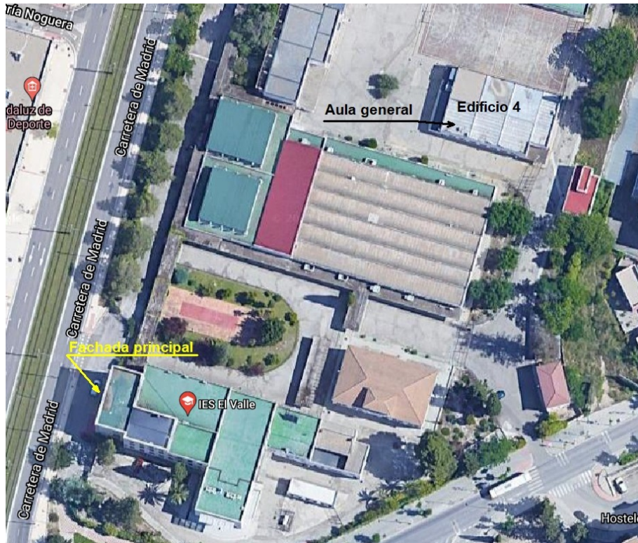
Imagen 2: Situación dependencias Fabricación Mecánica (Fuente: Google Maps)
