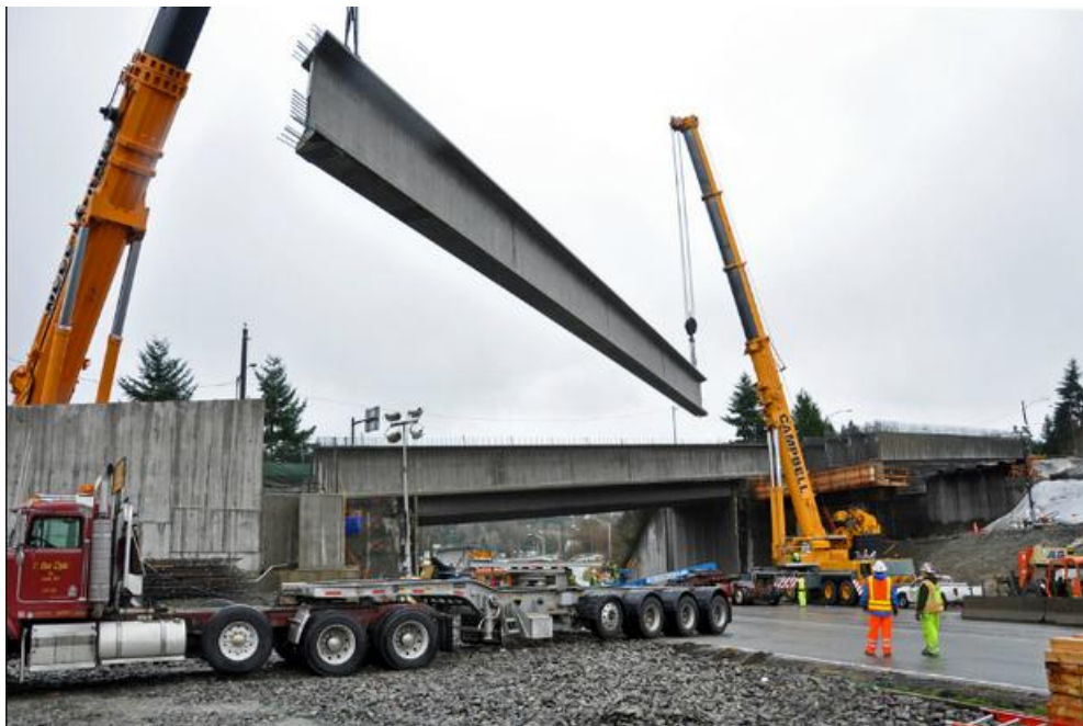
Figura 139: Colocación de la viga.[14]
