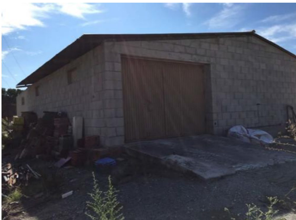
Fotografía 7: Nave agrícola para el almacenamiento de maquinarias y productos agrícolas afectada por la expropiación forzosa
