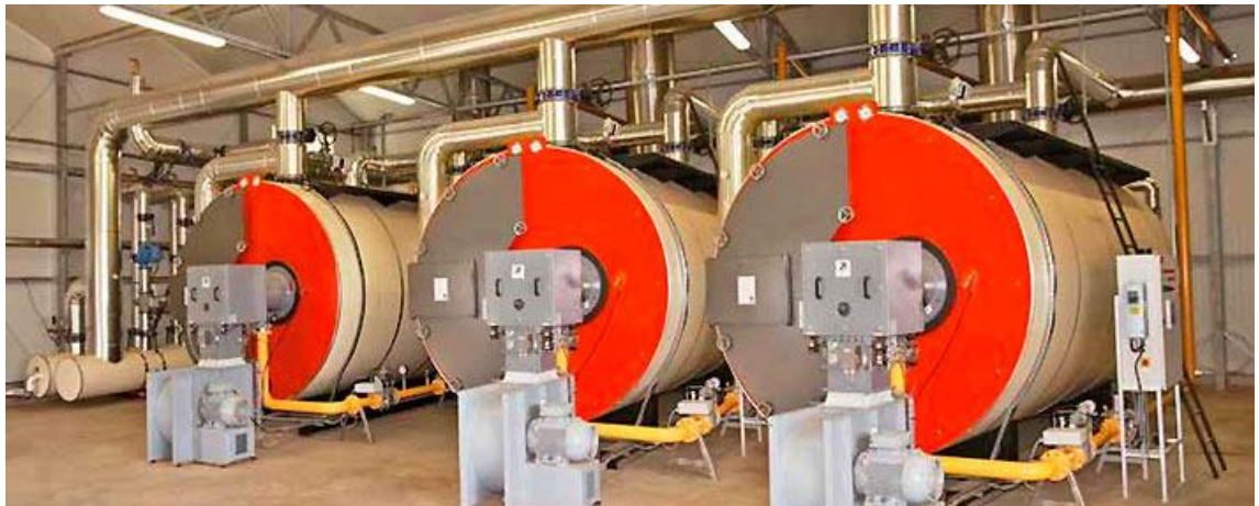
Ilustración 1.9: Calderas industriales de gas
