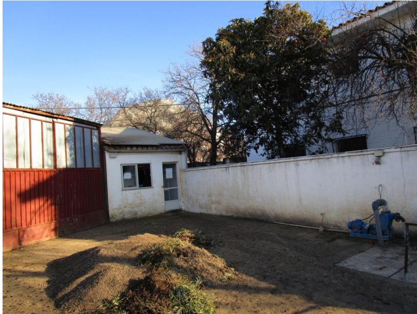
ILUSTRACIÓN 27. CASETA MANIOBRA DEL PATIO
