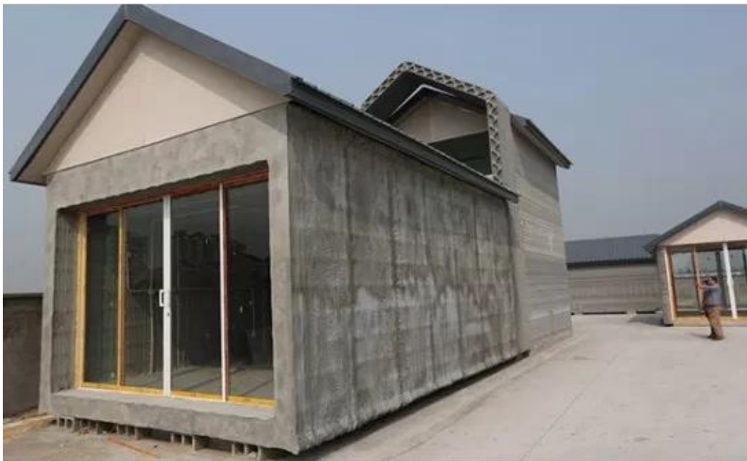
Figura 22. Casa fabricada con Impresión 3D
