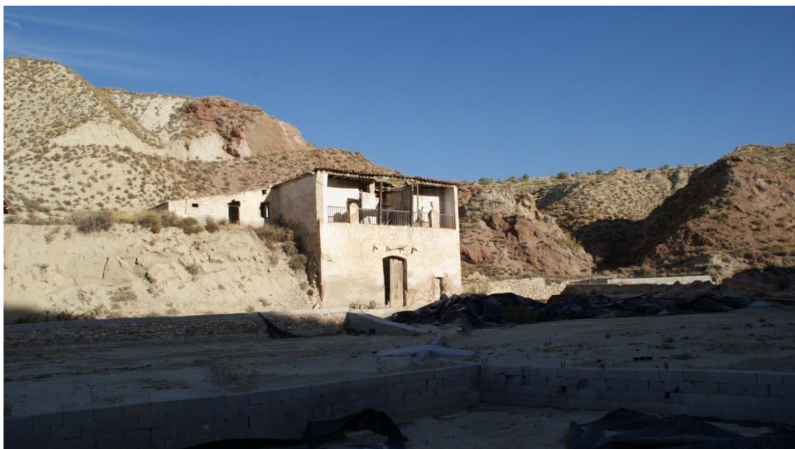
Fig.19: Vista frontal de la casa salinera del Chillar (Foto: Autor).
