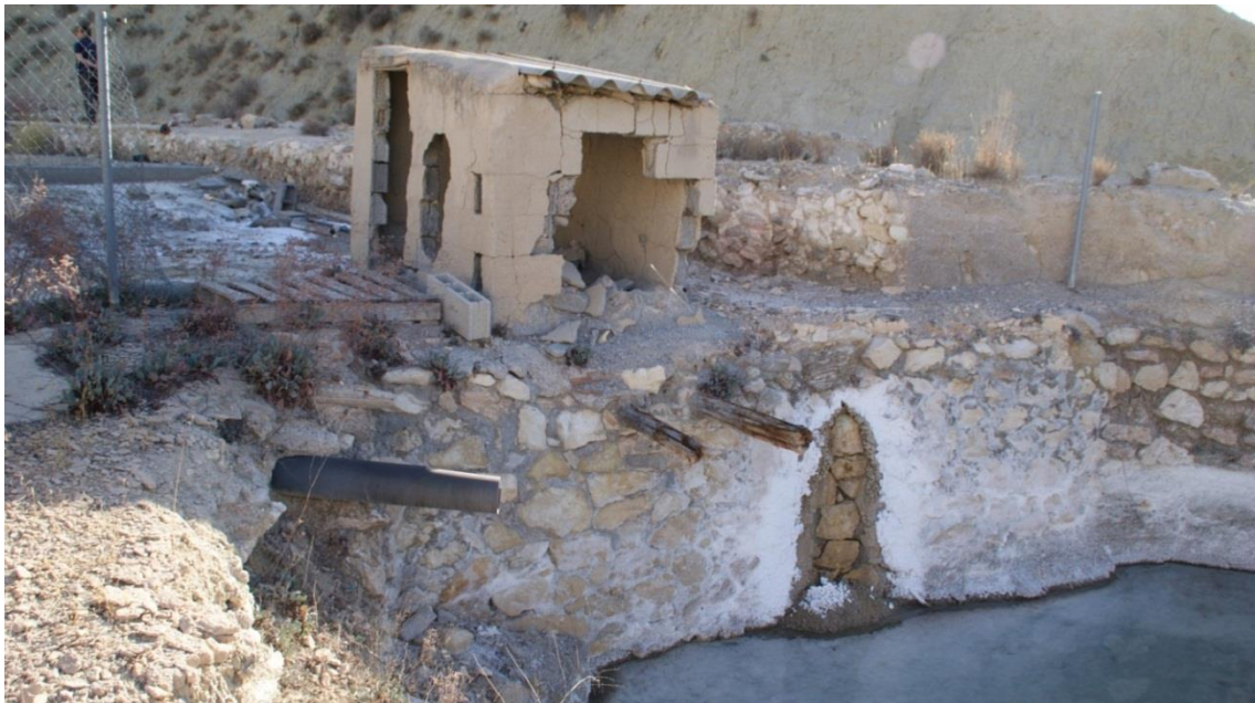
Fig.16: Mampostería y restos de estructuras de madera de la alberca Sur (Foto: Autor).
