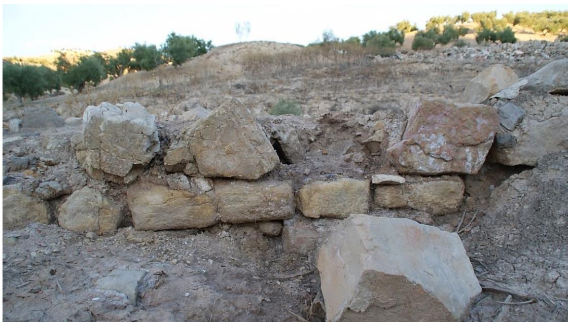
Fig.38: Detalle de los restos del muro de contención del margen occidental que limita con el arroyo (Foto: Autor).
