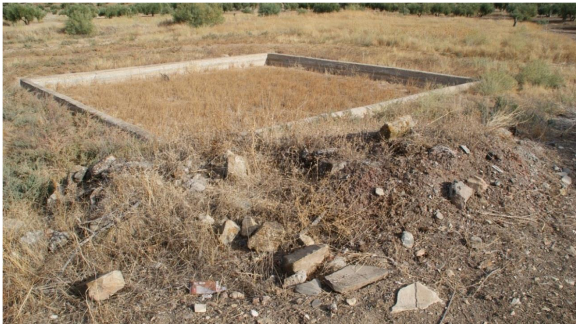
Fig.60: Estado actual d la alberca de la Orden (Foto: Autor).
