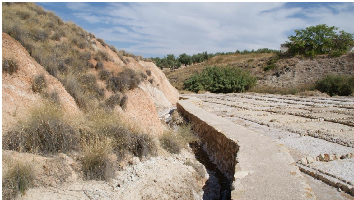
Fig.29: Muro de contención que bordea el Arroyo de las Salinas (Foto: Autor).
