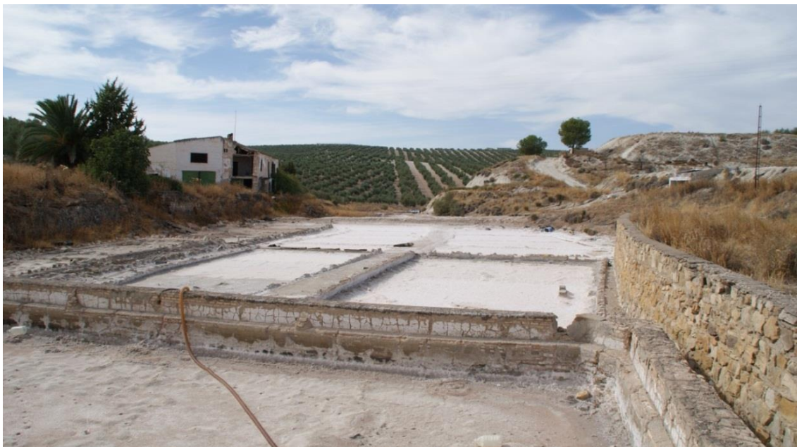
Fig.51: Vista del sector oriental de la salina del Brujuelo (Foto: Autor).
