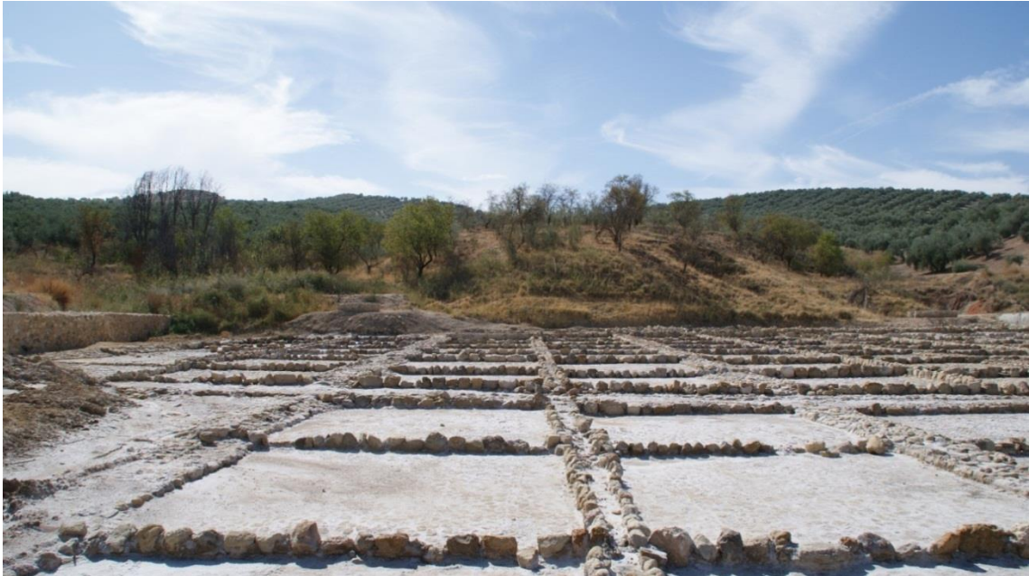
Fig.27: Vista de la distribución ortogonal de los cristalizadores (Foto: Autor)
