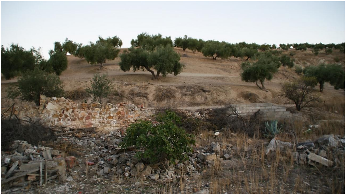
Fig.40: Escombros del Cortijo de la Salina del Puente Tablas, al fondo podemos ver dos tipos de muros, a la izquierda uno más antiguo fabricado a base de mampostería y cal y a la derecha uno más moderno hecho de bloques de hormigón (Foto: Autor).
