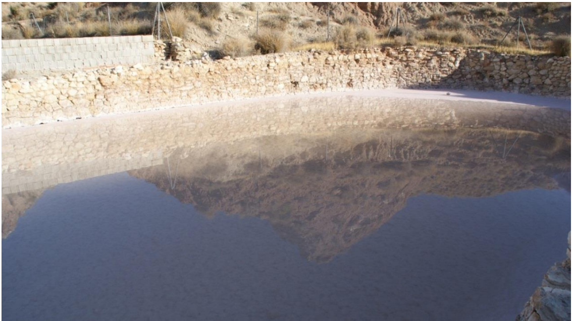
Fig.15: Muro de mampostería de la alberca Norte (Foto: Autor).
