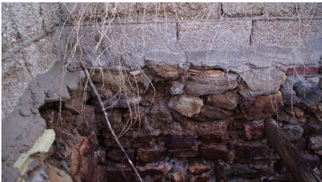
Fig.36: Paramento del pozo de la salina oriental donde podemos apreciar la superposición estratigráfica de los materiales de construcción, en primer lugar un cuerpo de mampostería trabada con mortero de cal y una viga de madera para la contención del muro y un segundo cuerpo de bloques de hormigón (Foto: Autor).
