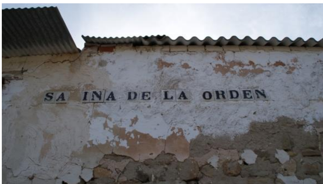
Fig.63: Cartela en la fachada principal (Foto: Auto).
