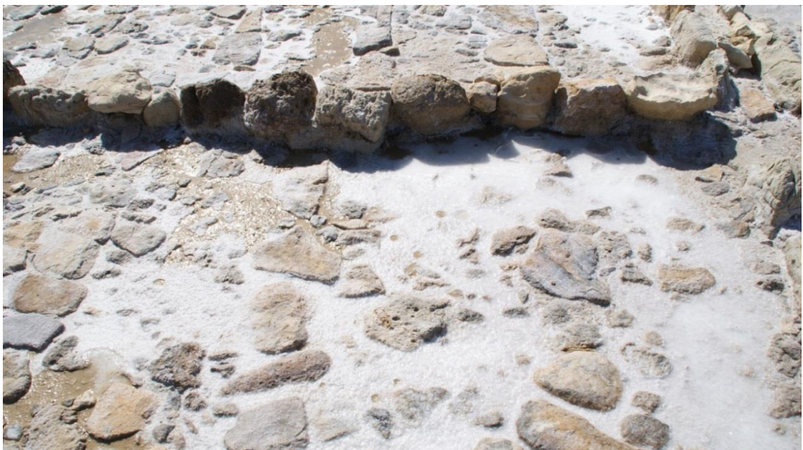
Fig.28: Detalle del pavimento de los cristalizadores con restos de sal en su superficie (Foto: Autor).
