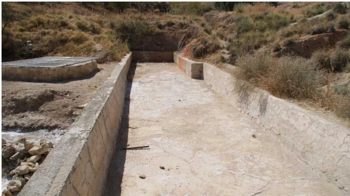
Fig.26: Alberca situada en la cabecera de la salina que conecta con el pozo occidental (Foto: Autor).
