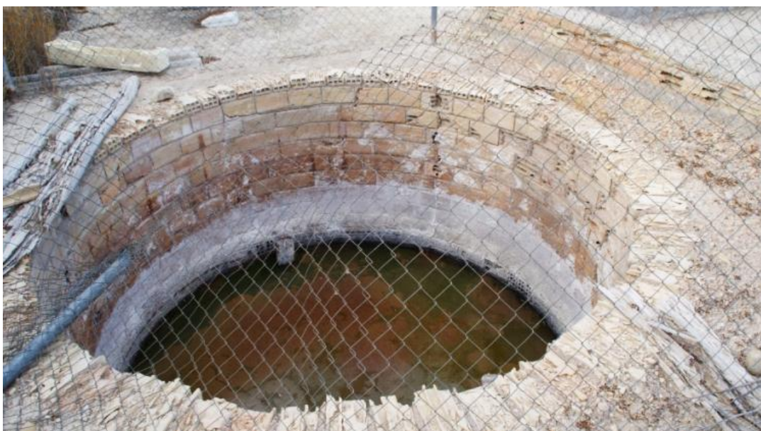
Fig.7: Pozo hecho de ladrillo hueco en la salina del Marques (Peal de Becerro, Jaén), (Foto: Autor).
