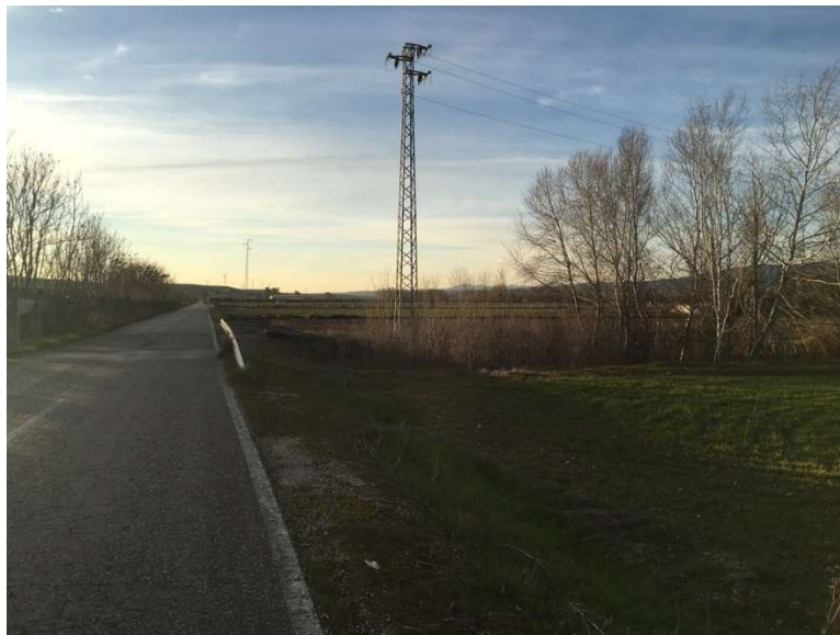
Figura 27: Torres de Alta Tensión del margen norte de la Autovía A-4 / Reportaje Fotográfico Propio
