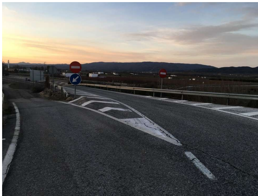
Figura 9.2: Enlace PK 326 y acceso a Centro Logístico Intermodal / Reportaje Fotográfico Propio
