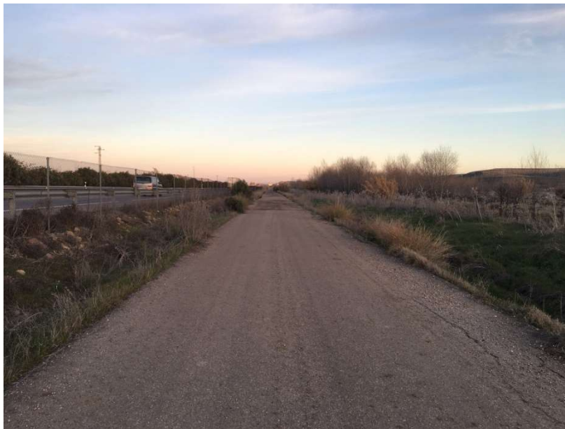
Figura 14: Vía de servicio del margen sur de la Autovía A-4 / Reportaje Fotográfico Propio
