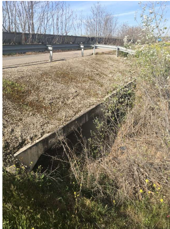
Figura 26: Marcos de hormigón en arroyo del margen norte de la Autovía A-4 / Reportaje Fotográfico Propio
