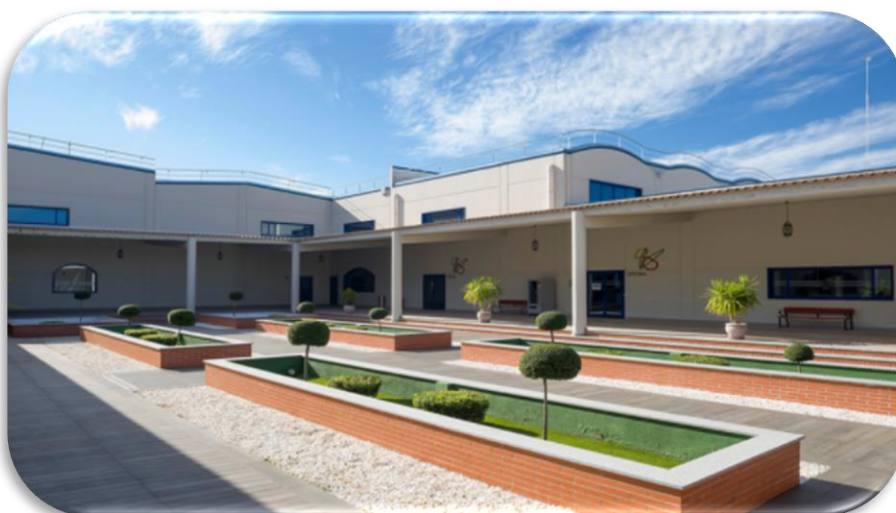
Ilustración 5. Entrada a las instalaciones de la almazara.
