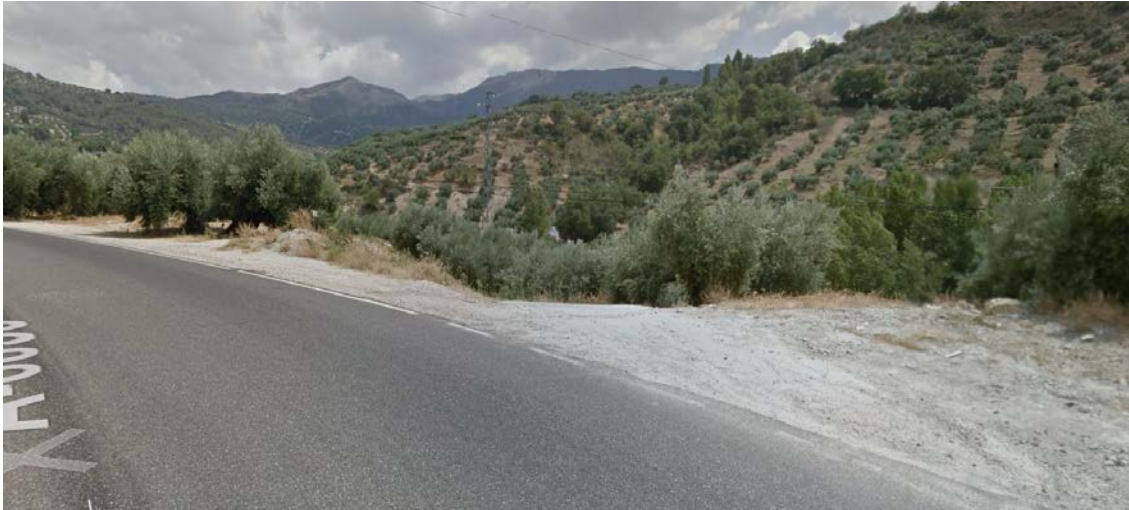
Ilustración 20. Salida de A-6050 hacia cámara de carga
