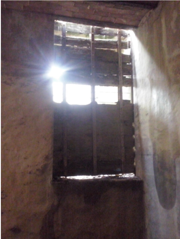
Ilustración 35A. Compuerta acceso cámara de carga
