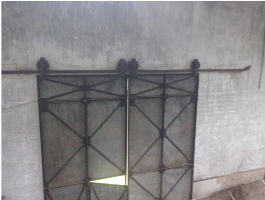
Ilustración 10. Puerta de acceso al edificio
