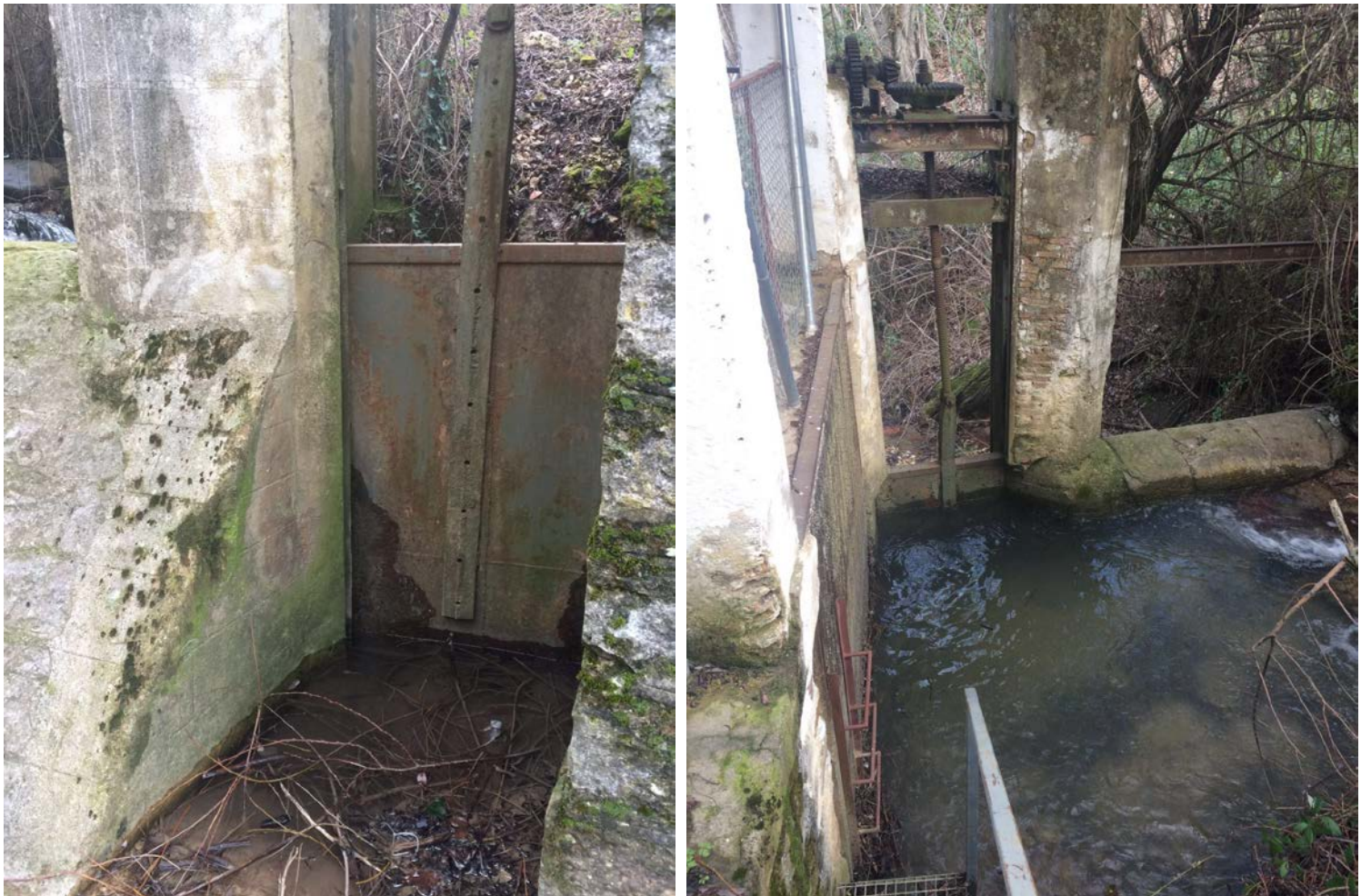
Ilustración 40A y 40B. Compuerta del azud
