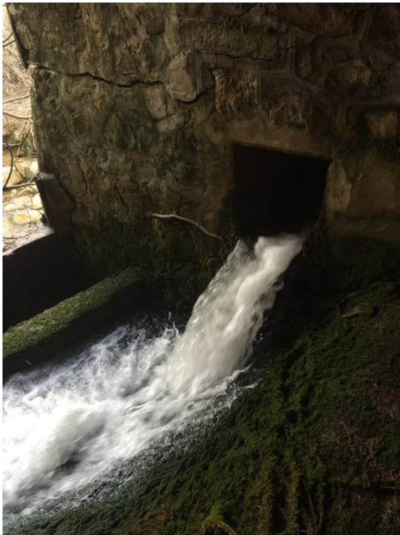
Ilustración 50. Desembocadura del canal aliviadero en el desagüe de la central
