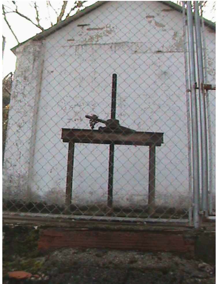
Ilustración 41A y 41B. Compuerta de entrada al canal
