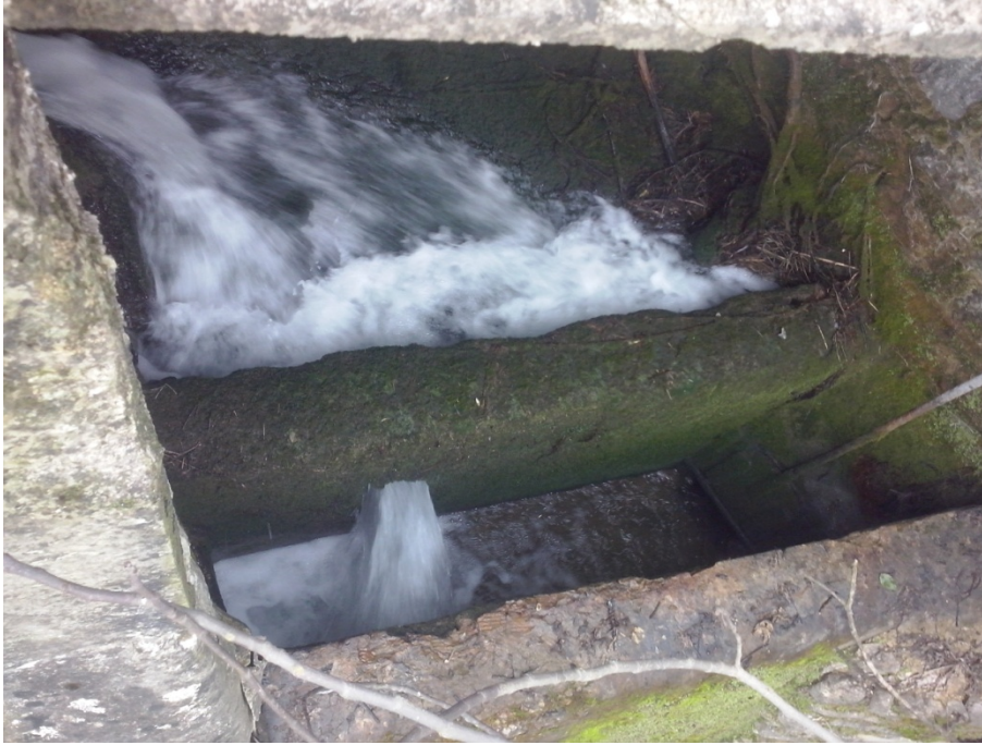
Ilustración 54. Desembocadura del canal aliviadero en el desagüe de la central, inicio del canal
