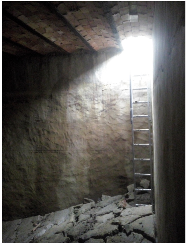
Ilustración 36B. Acceso interior cámara de carga
