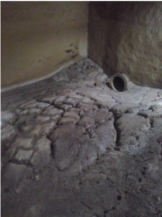
Ilustración 36A. Interior cámara de carga, inicio tubería forzada
