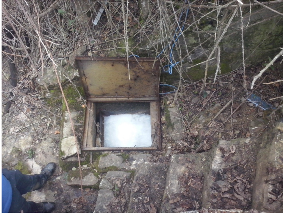
Ilustración 49. Parte subterránea del canal aliviadero
