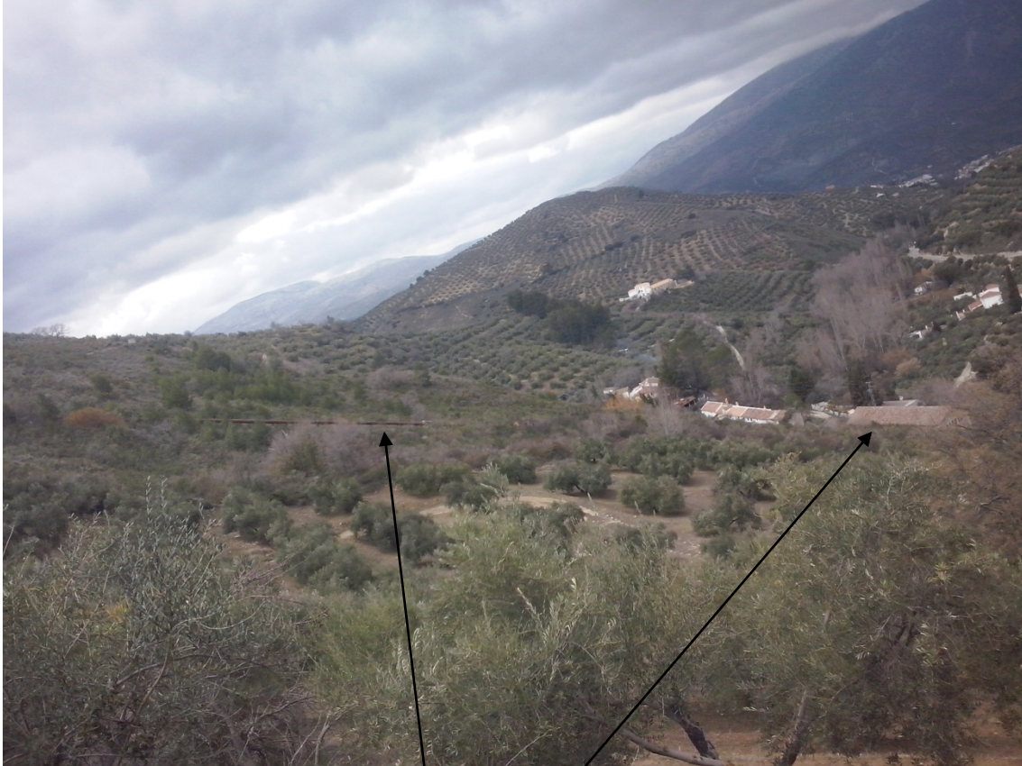
Ilustración 39. Tubería forzada y edificio de central
