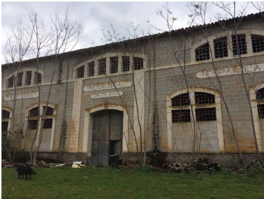
Ilustración 6. Fachada principal del edificio
