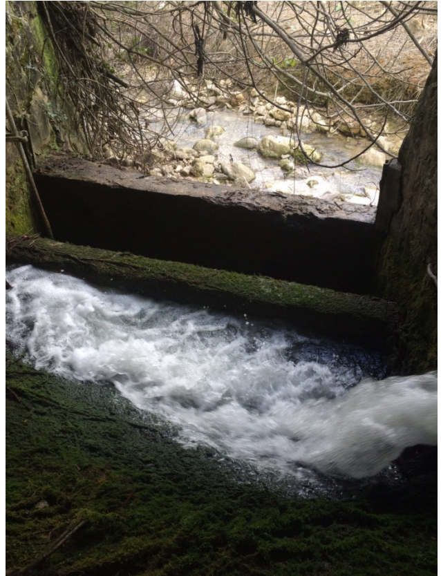
Ilustración 52B. Desembocadura del canal aliviadero
