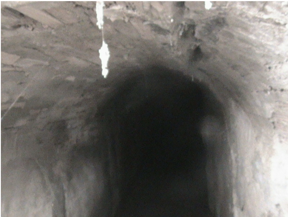
Ilustración 26. Interior de canal desde chimenea
