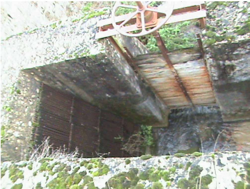
Ilustración 34. Compuerta canal de desagüe
