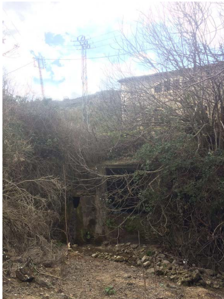
Ilustración 55. Desembocadura del desagüe y edificio de la central
