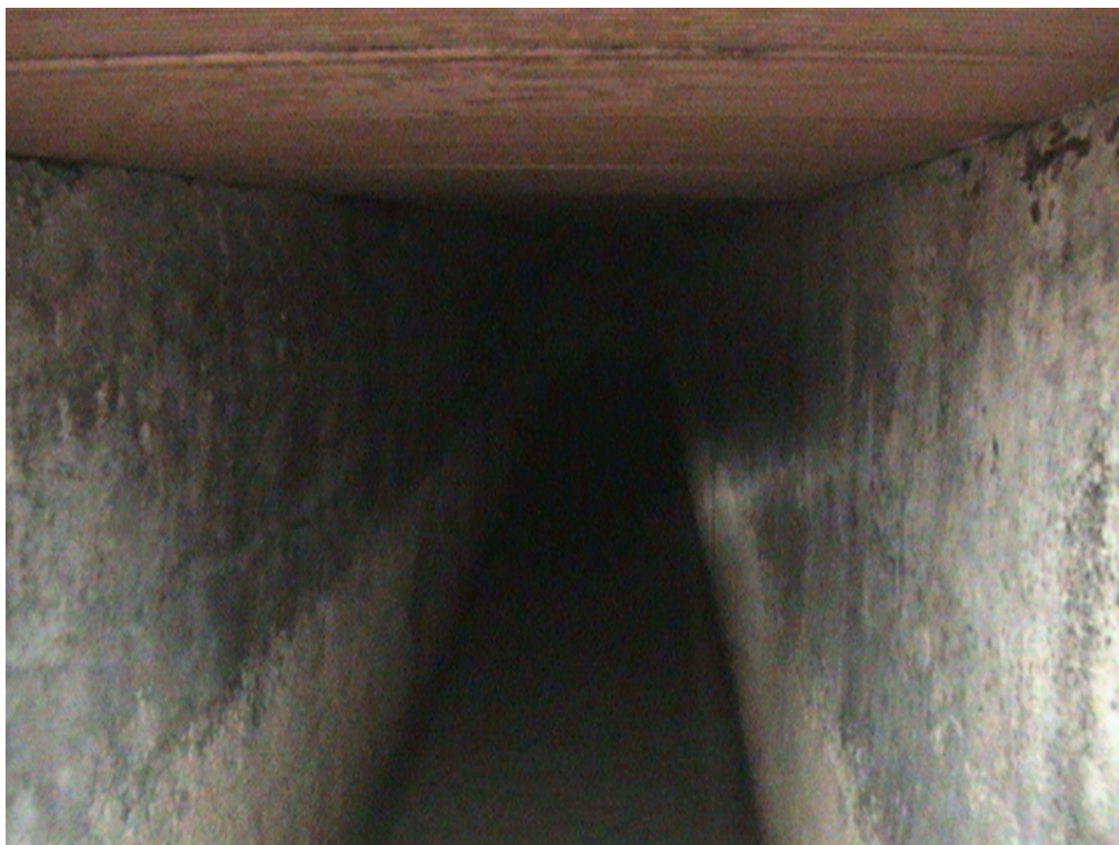
Ilustración 29. Interior parte cubierta reparada del canal
