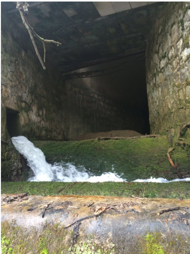
Ilustración 53A. Desembocadura del desagüe
