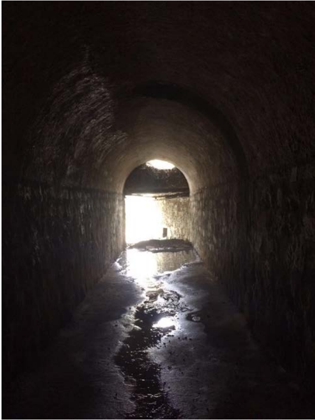
Ilustración 52A. Túnel hacia desembocadura
