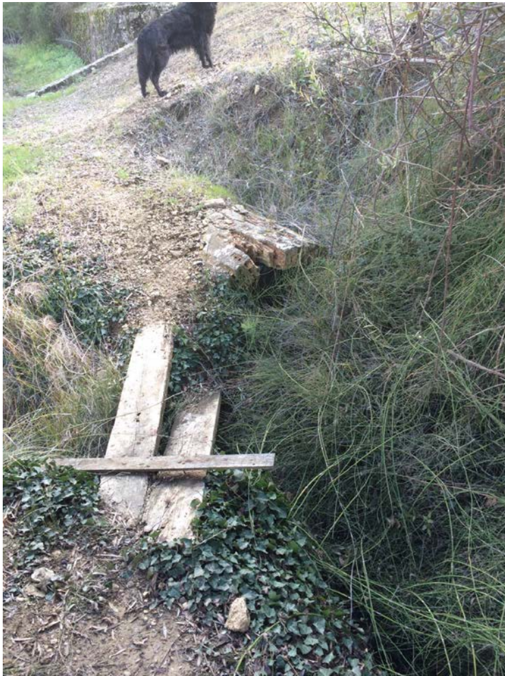
Ilustración 25A. Zona donde se ha derruido la cubierta del canal
