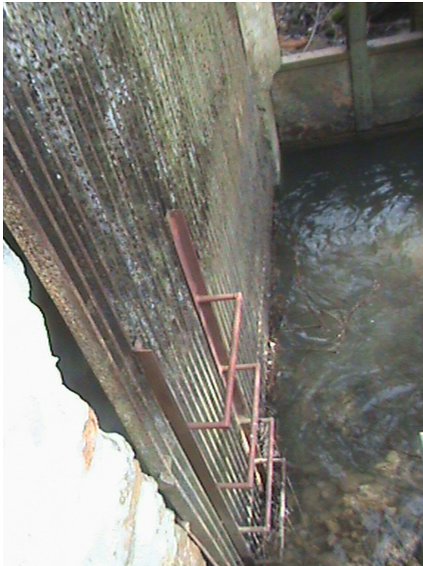
Ilustración 46. Rejilla del azud
