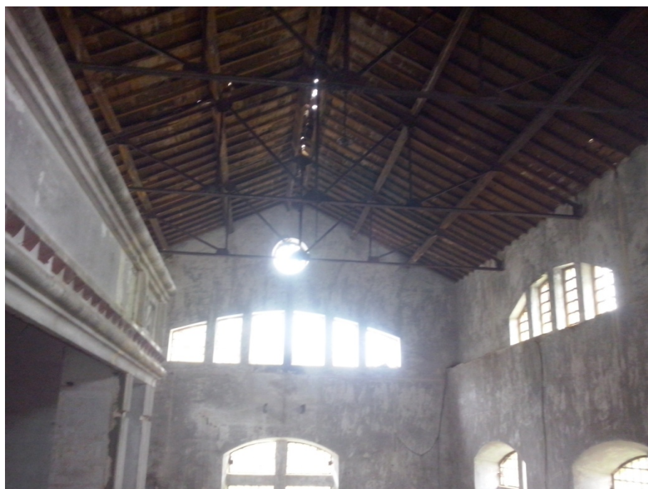
Ilustración 15. Cubierta del edificio
