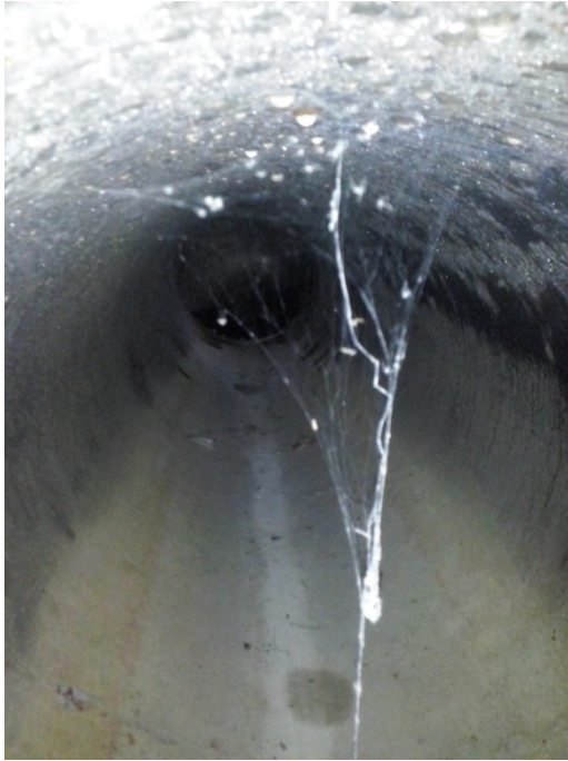
Ilustración 37A. Interior tubería forzada
