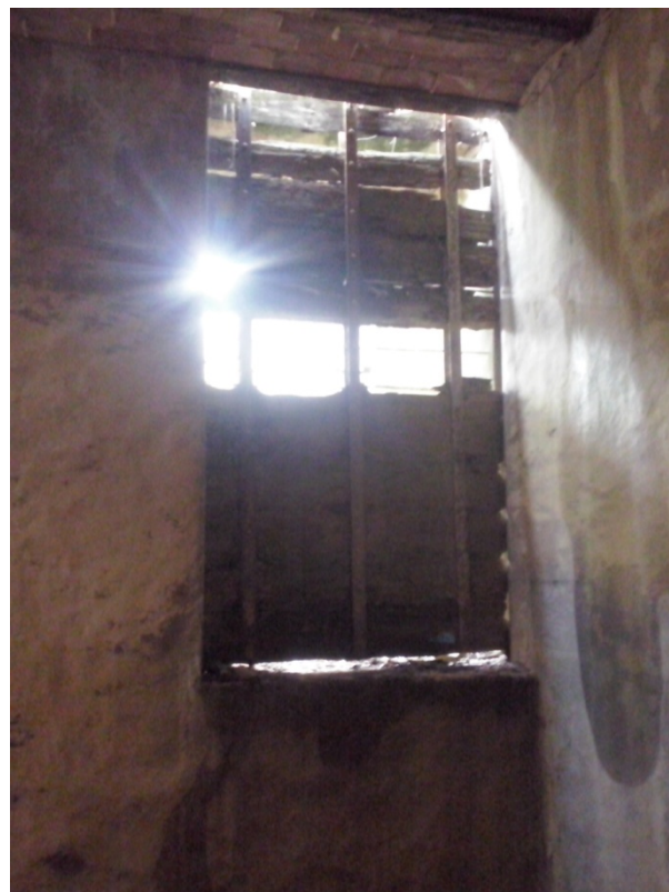
Ilustración 45. Compuerta de entrada a cámara de carga
