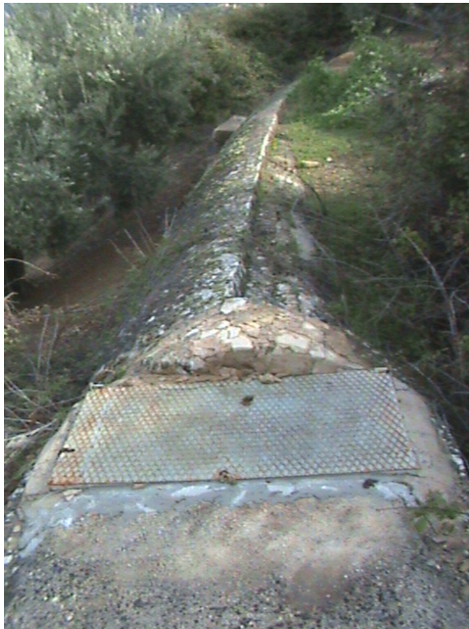
Ilustración 28. Cubierta original y zona de cubierta reparada por Aqualia
