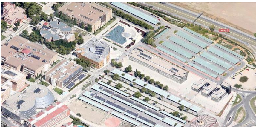
Ilustración 1: Zona de actuación
