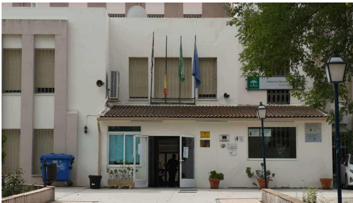
Figura 55. Edificio del instituto de educación secundaria I.E.S. Miguel Sánchez López (elaboración propia)
