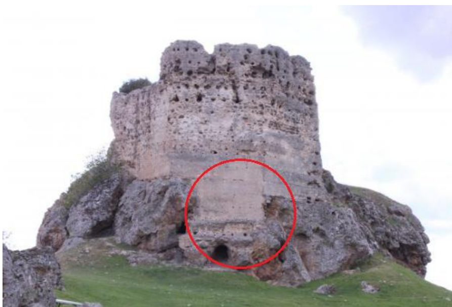
Figura 37. Falso despiece presente en la cara norte de la torre hexagonal del castillo de las Navas de Tolosa.
