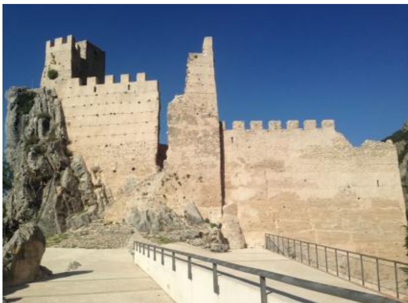
Figura 36. Detalle de falso despiece en sillería en el castillo de la Iruela (Fotografía de la autora)
