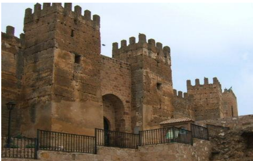
Figura 35. Detalle del falso despiece en sillería del castillo de Baños.
