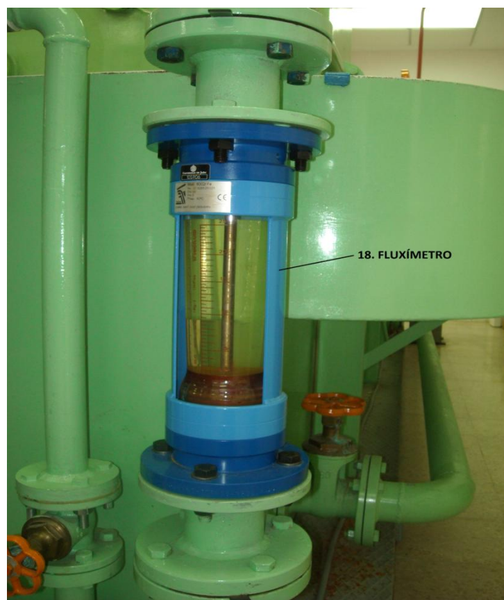
Figura 10. 13. Fluxímetro.
