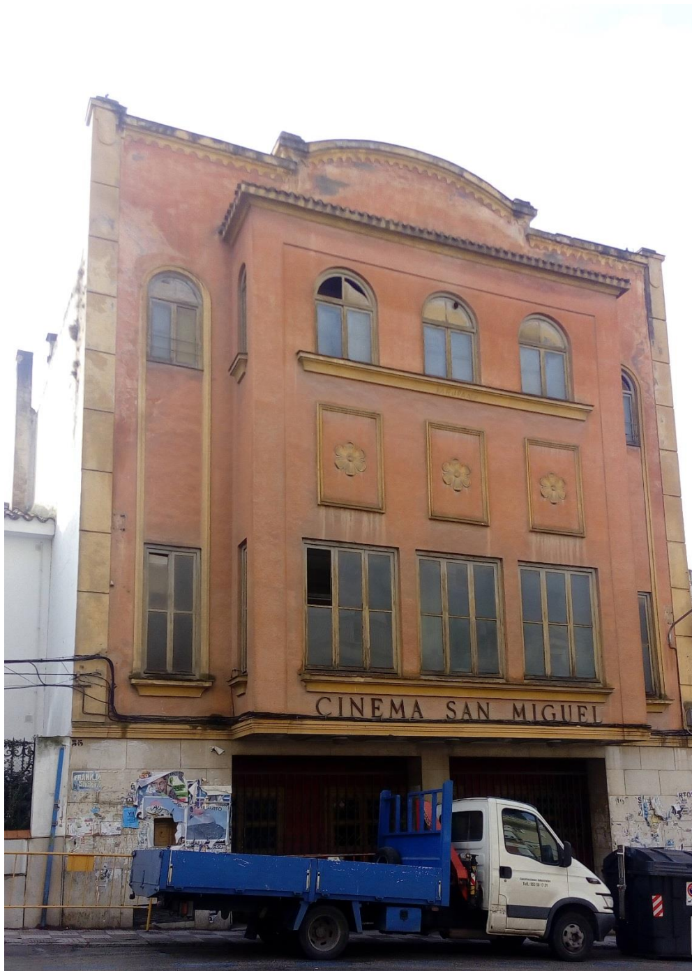
Imagen 5: Estado actual del cine San Miguel
