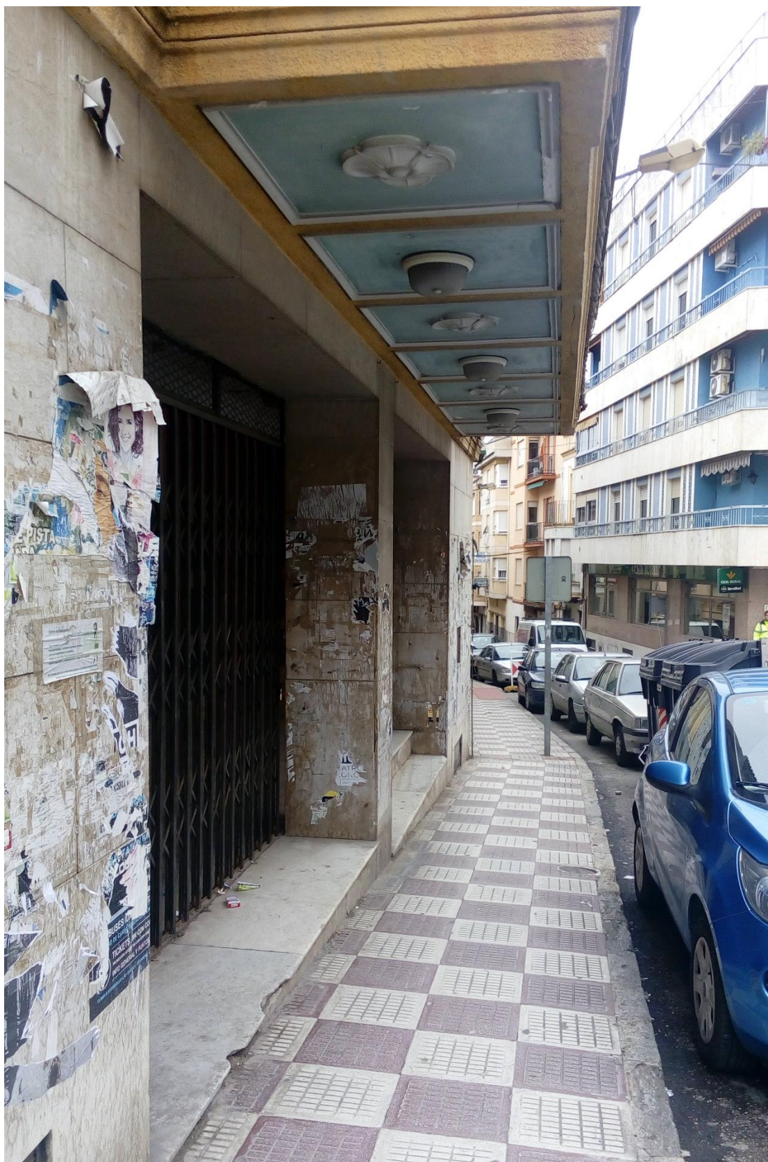
Imagen 6: Estado de conservación de la fachada
