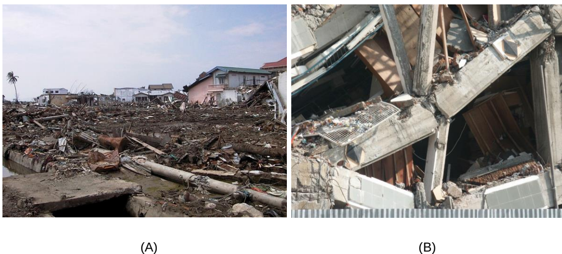
Figuras 7 (A y B). En las figuras adjuntas se muestran algunos de los daños producidos por el tsunami en viviendas familiares, hoteles turísticos. Tomado de: (Ghobarah et al., 2006).
