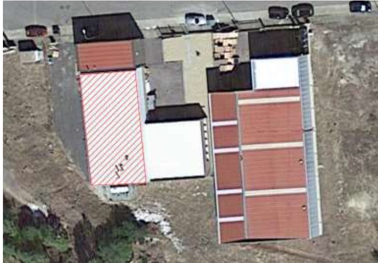
Ilustración 1. Emplazamiento de la instalación
