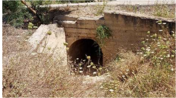
Ilustración 3. Obras de drenaje transversal actuales.
