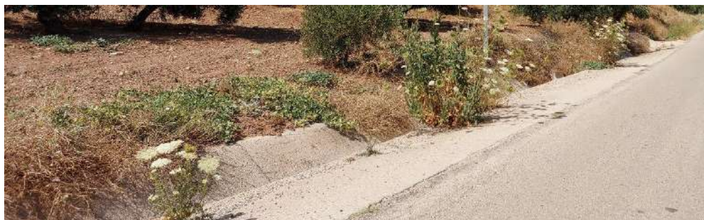
Ilustración 2. Drenaje longitudinal actual.
