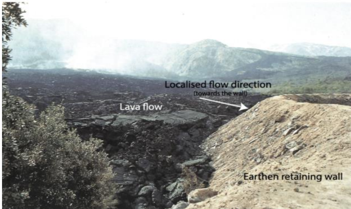
Figura 5.6. Imagen que muestra la contención del flujo de lava de la erupción del Etna de 1991-1993 por una barrera de tierra, al tiempo que se construía un canal artificial ladera abajo para redirigir el flujo (Tsang y Lindsay, 2020).
