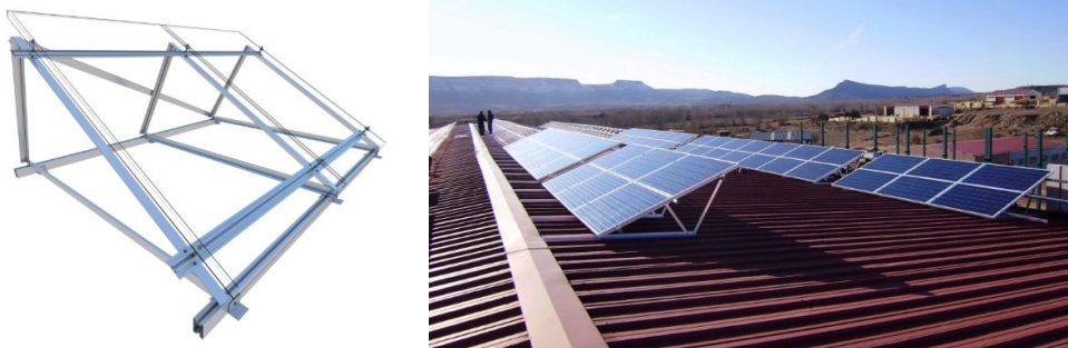
Figura M.2 – Montaje de módulos en cubierta
