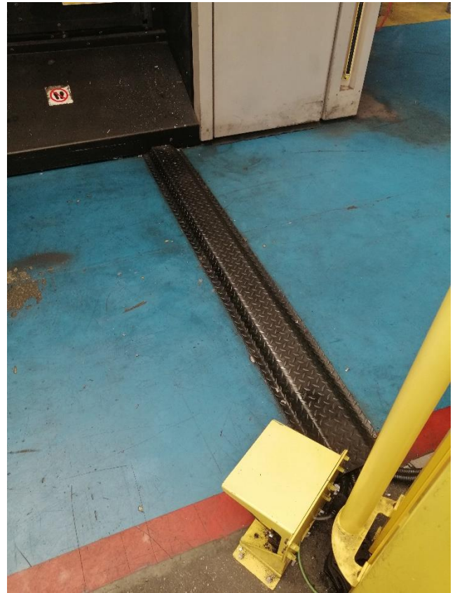
Imagen 14 y 15. Canaletas de seguridad para cubrir los cables, evitando así caídas al mismo nivel.
