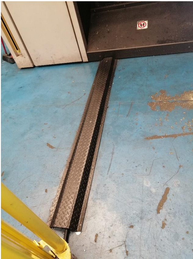
Imagen 14 y 15. Canaletas de seguridad para cubrir los cables, evitando así caídas al mismo nivel.
