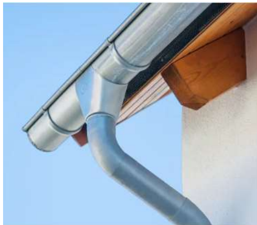
Imagen 25. Bajante del canalón
