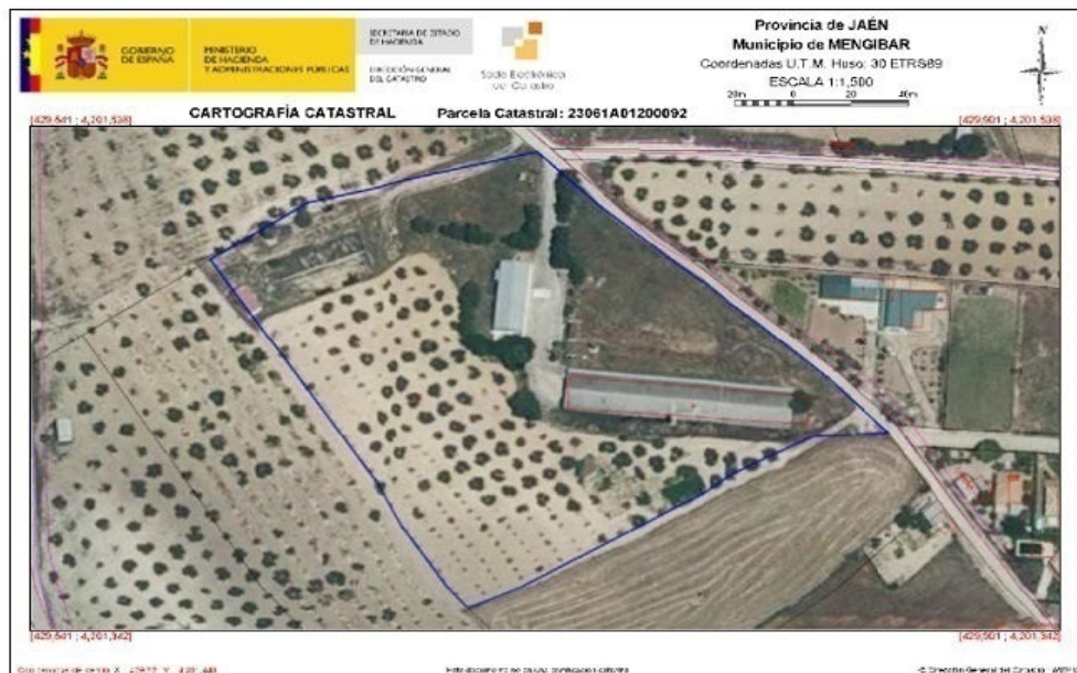
Ilustración 1. Vista aérea de la propiedad
