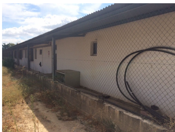
Ilustración 4. Vista lateral izquierda de la propiedad (fachada norte)
