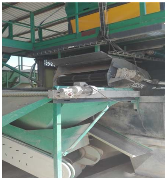
Figura A1.4. Máquina lavadora de aceituna y tolva de pesaje.
