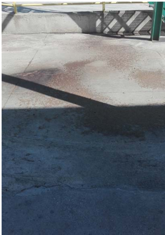
Figura 5.30. Limpieza del suelo exterior (recogida de hueso triturado) de la Sala de máquinas
