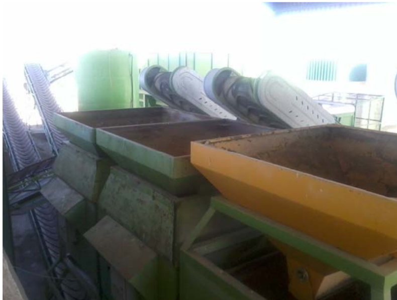
Figura A2.8. Presencia de suciedad en las limpiadoras y lavadoras de aceituna.
