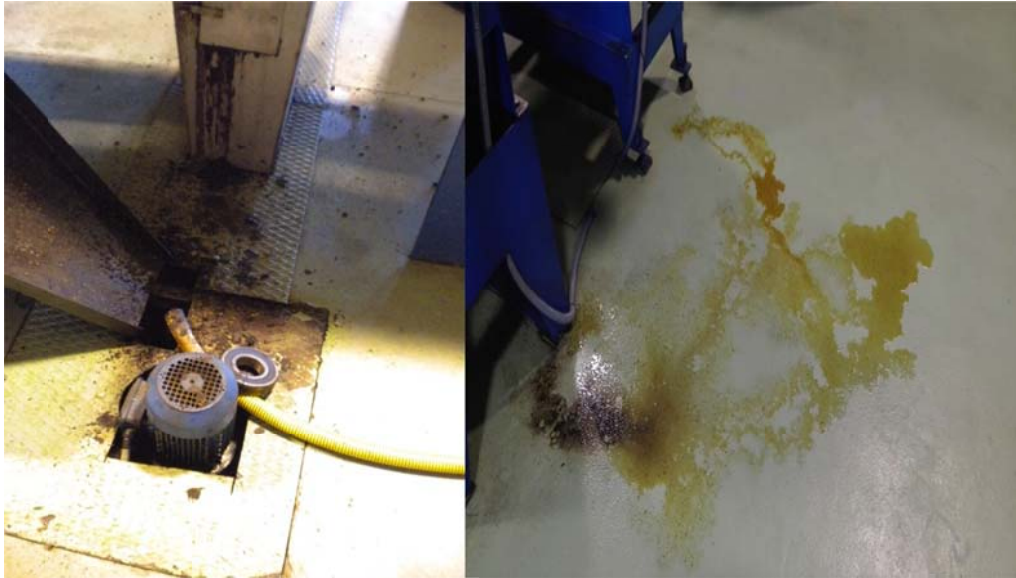
Figura A2.17. Presencia de suciedad en el suelo del puesto de trabajo.
