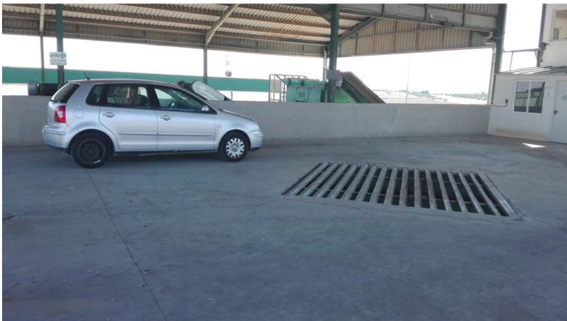
Figura 5.37. Acceso de vehículos y remolques a la zona de trabajo.
