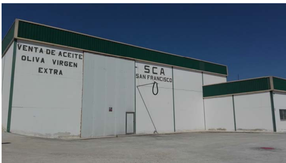
Figura 5.1. Fachada Principal de la Cooperativa
