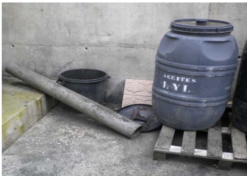
Figura 5.6. Elementos a eliminar de la Sala de máquinas
