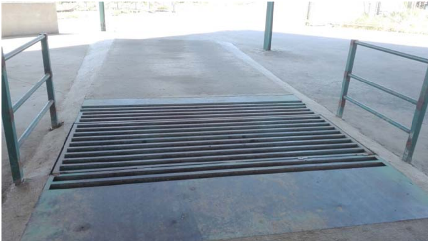
Figura A1.1. Tolvas para la recepción y la selección de la aceituna.
