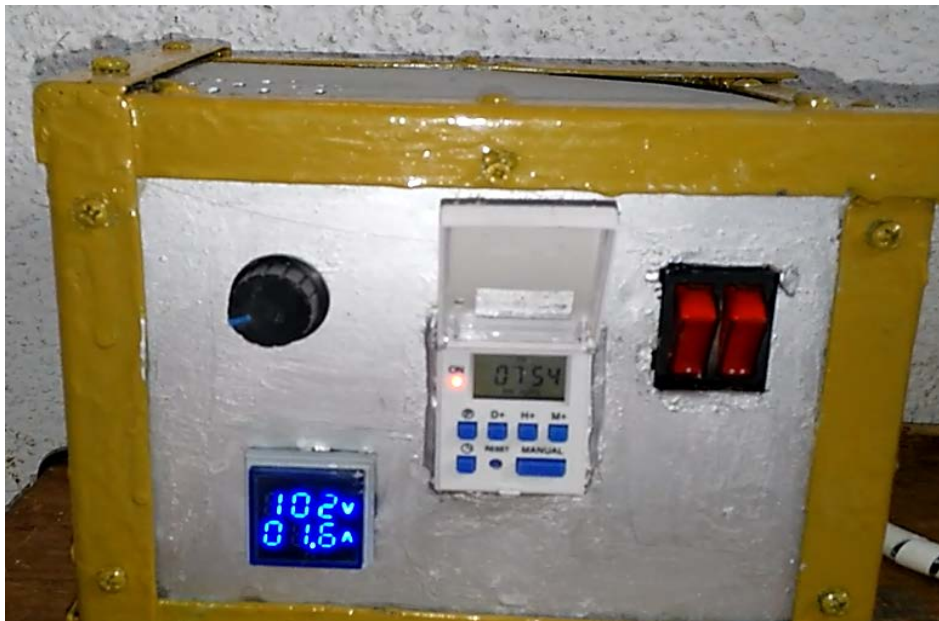
Ilustración 7. Vista 4 de la bomba hidráulica de las actividades. Fuente: Elaboración propia.
