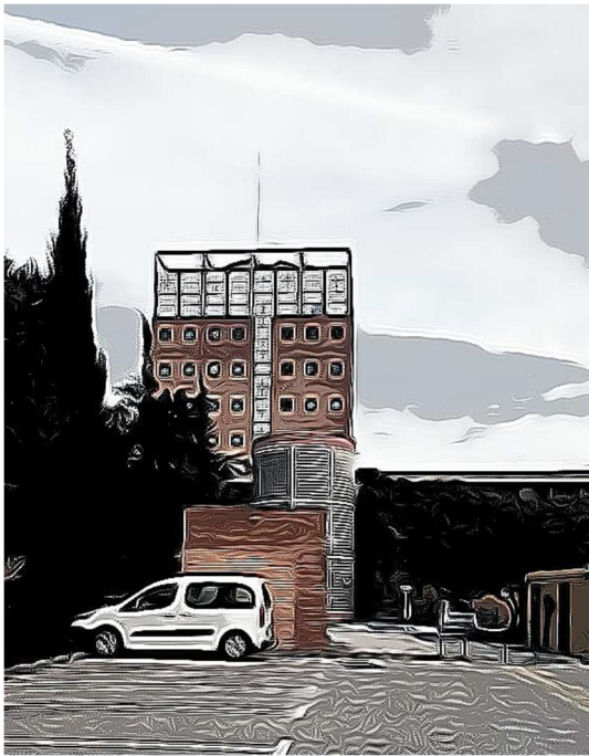
Figura 10. Parking trasero de la Facultad. Fuente: elaboración propia.
